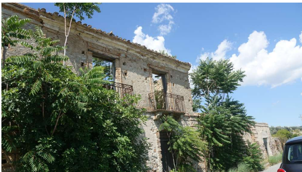
Foto 8. Prospetto esterno lato strada statale 2 dir. Località Cullaro
