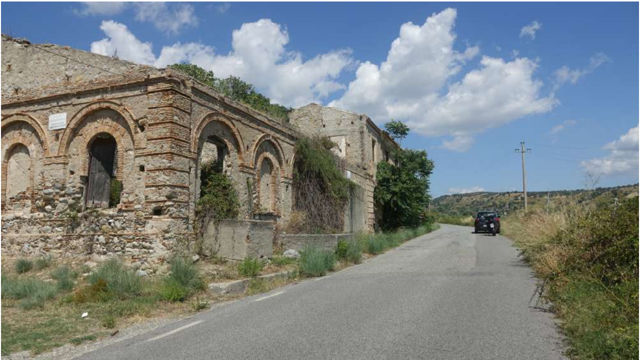
Foto1. Prospetto principale – strada Statale 2 dir. Località Cullaro.
