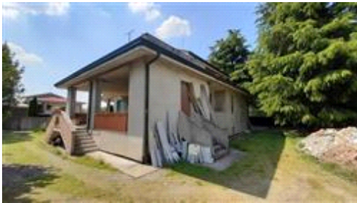
Vista Edificio - Fronte Sud-Est
