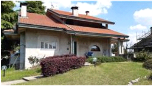
Vista Edificio - Fronte Ovest verso area pertinenziale sistemata a verde
