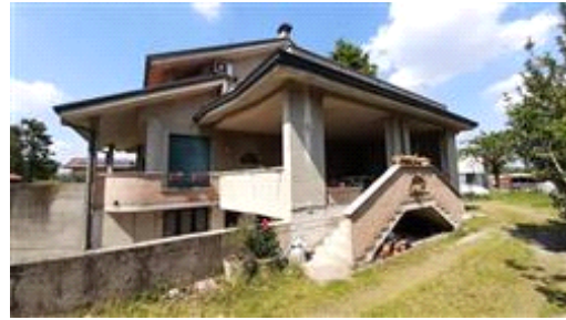
Vista Edificio - Fronte Sud-Ovest
