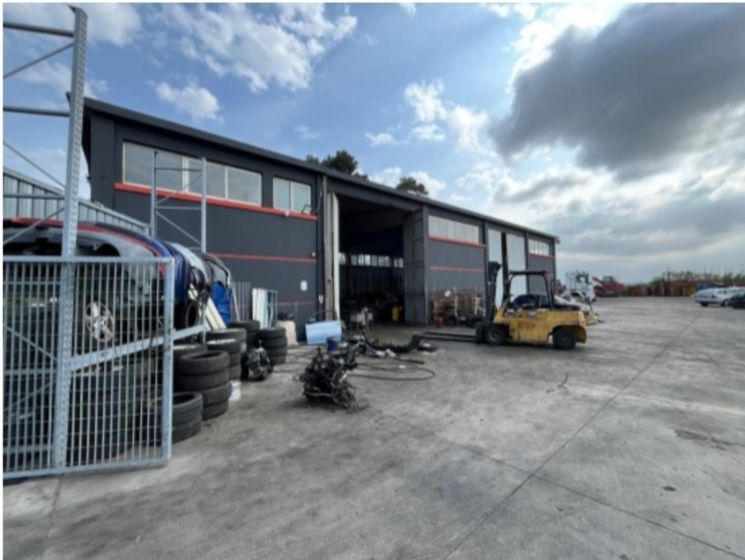
Prospetto nord - est capannone
