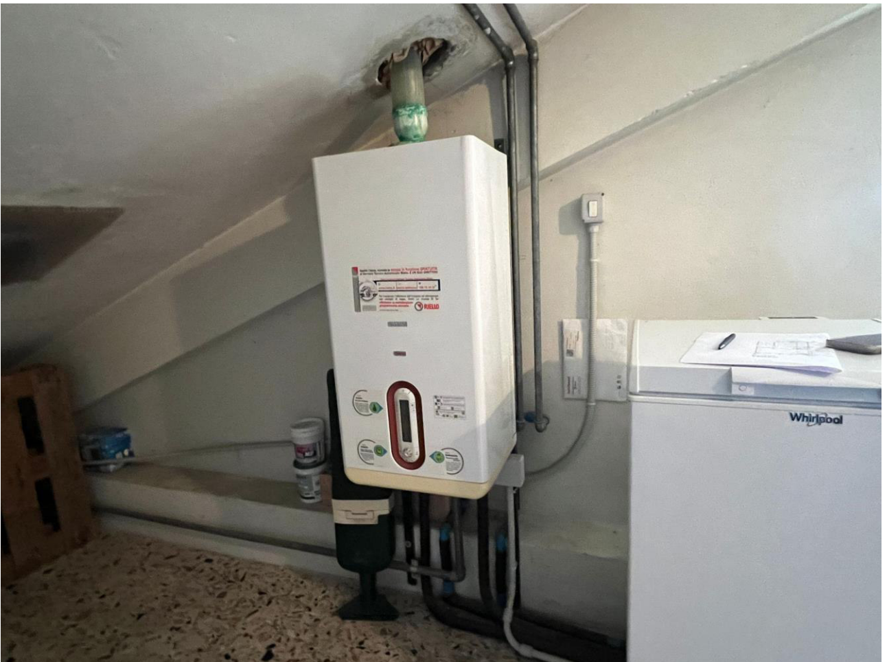
Piano 4° sottotetto – Soffitta
