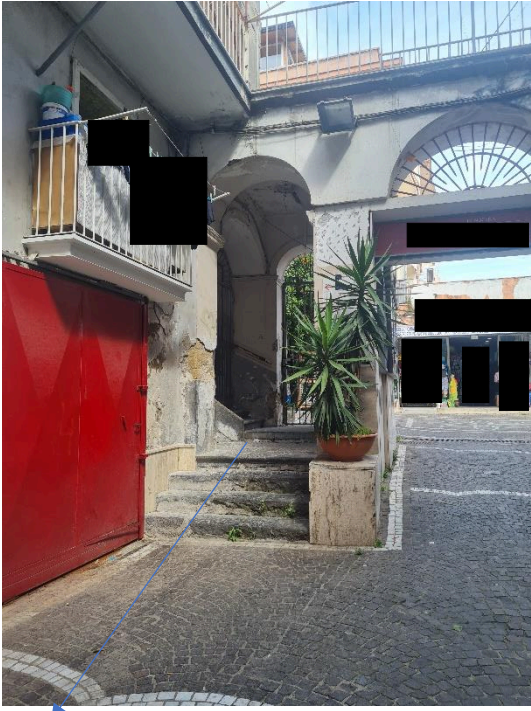
Pianerottolo di accesso al sottoscala (sub 15)
