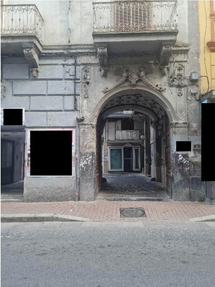
Napoli, Via Vittorio Emanuele III n. 48 – quartiere Secondigliano
