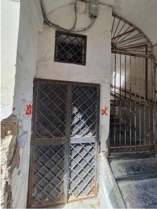
Porta di accesso al sottoscala
