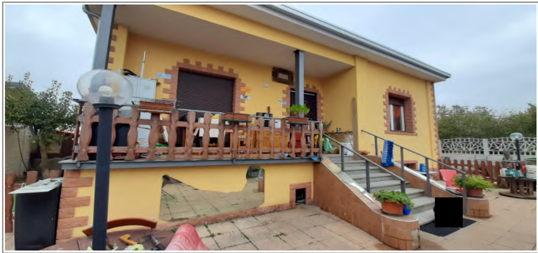
FRONTE SU VIA ADAMELLO
