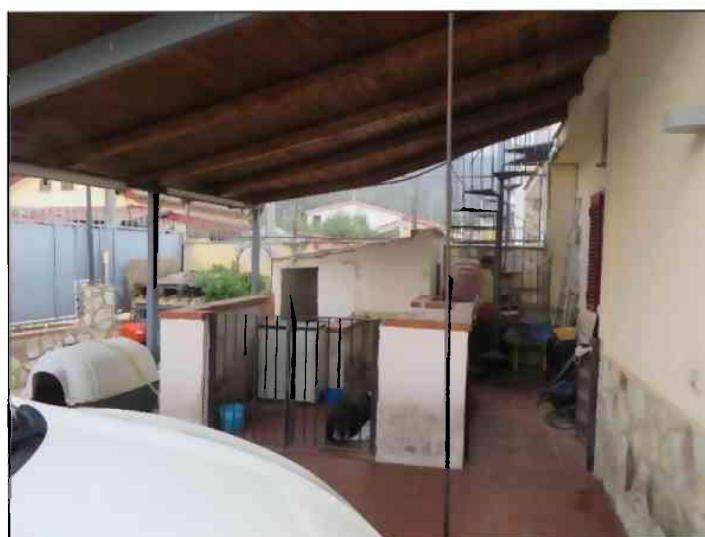
Tettoia adiacente l'ingresso
