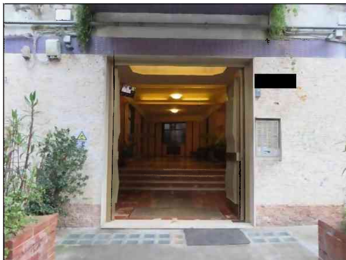
Portone di ingresso dell'edificio
