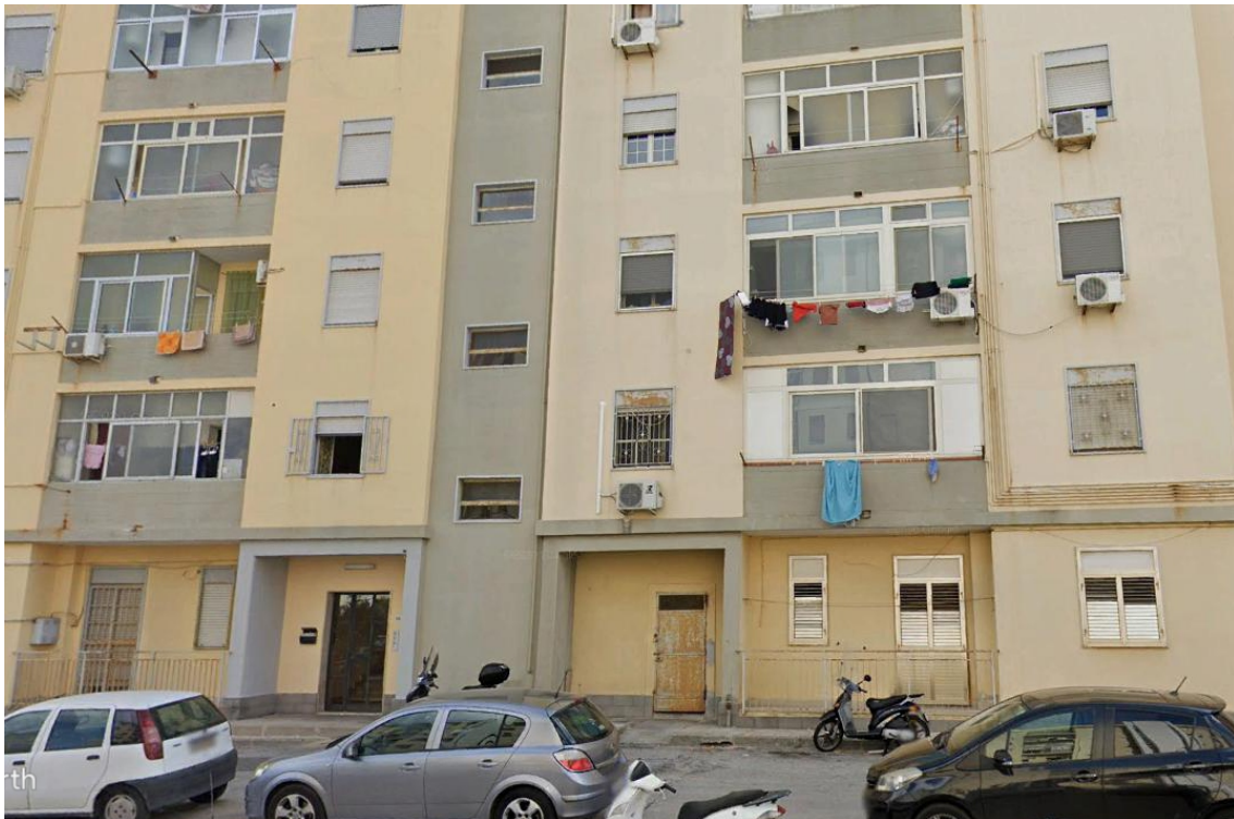
2_l'edificio dall'ingresso di Viale Algeri
