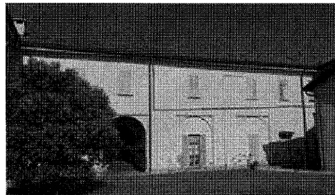
appartamento p. primo sub. 39 - vista da cortile interno
