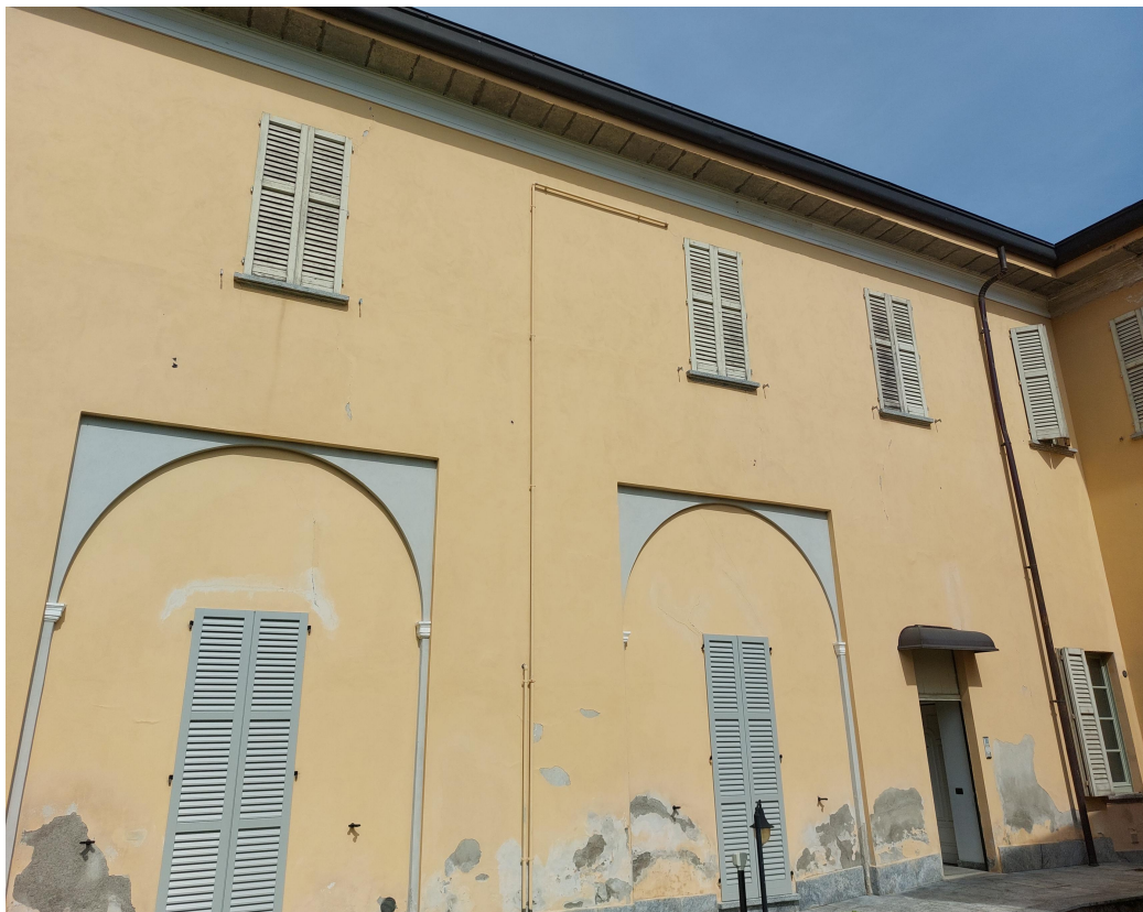
App. P. primo - Vista ingresso cortile interno
