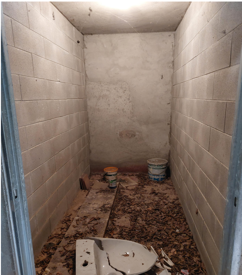
Cantina p. interrato
