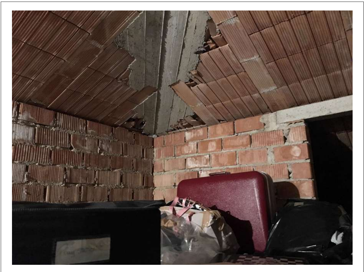
FOTO 32: Piano SOFFITTA - Vista dello spazio centrale.
