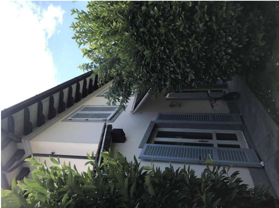
FOTO 8: Vista del fronte posteriore con la porta a servizio della Cucina.
