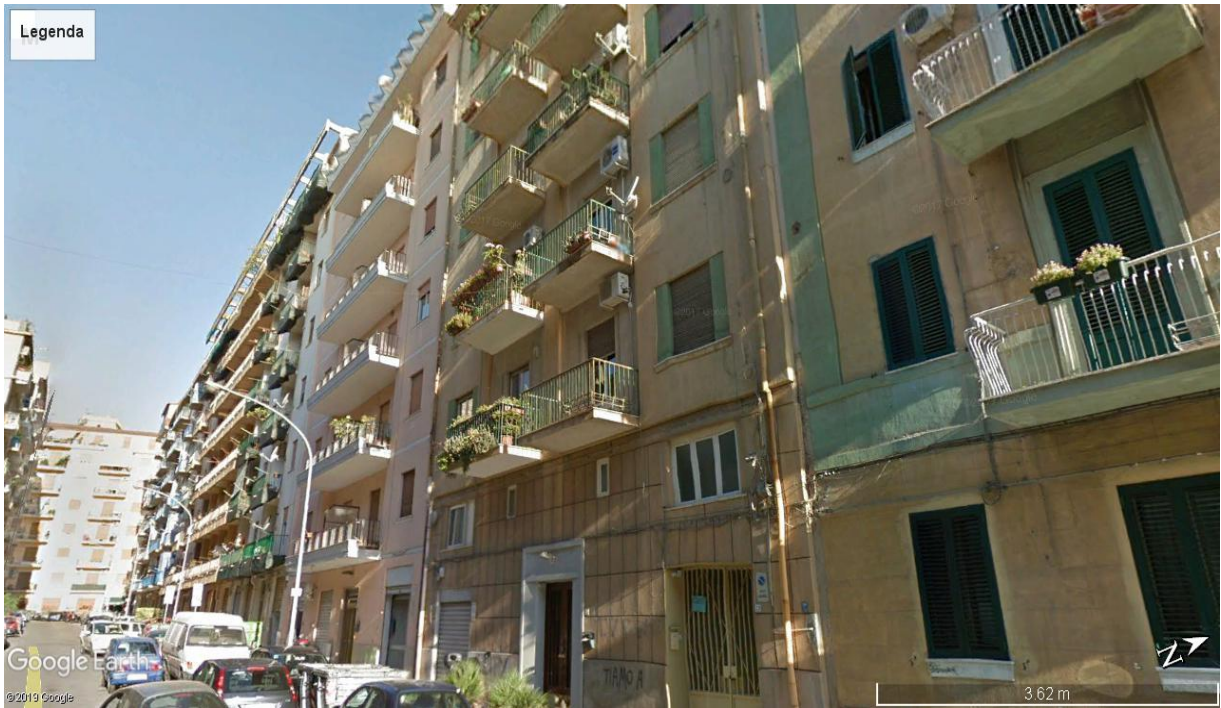
Prospetto principale su via C. Tomasi
