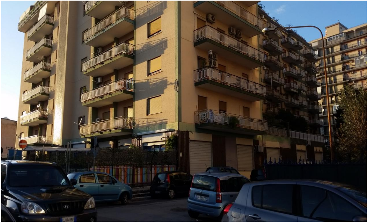
Prospetti principali ad angolo su via R. Montuoro e via G. Cosentino
