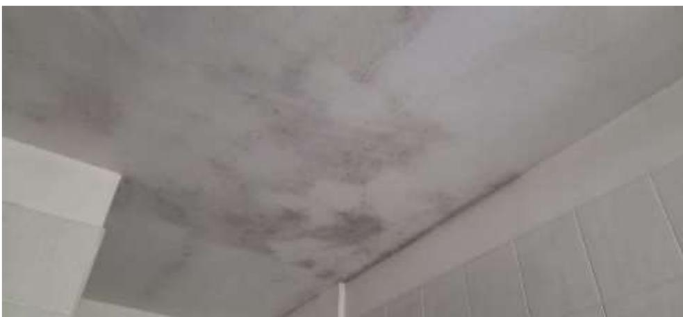
**Figura 11 dettaglio soffitto bagno con aree soggette a formazione di muffa**
