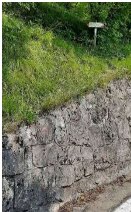
Figura 17 accesso al sentiero CAI n. 544 dalla SP64 che porta alla P.lla 169
