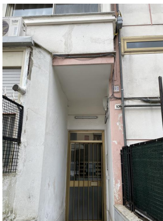
Foto 3 – Il portoncino di ingresso
