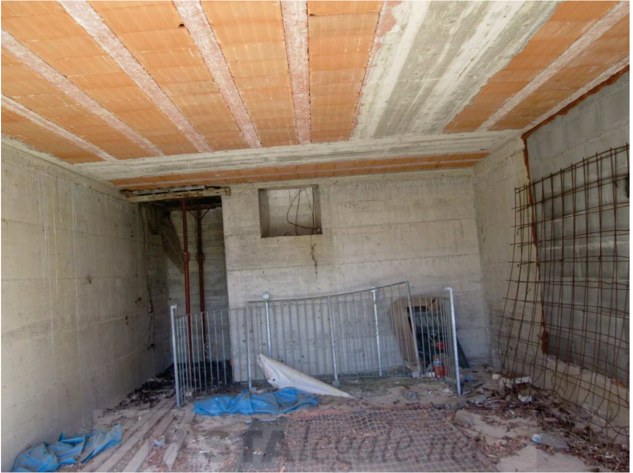
Interno piano interrato
