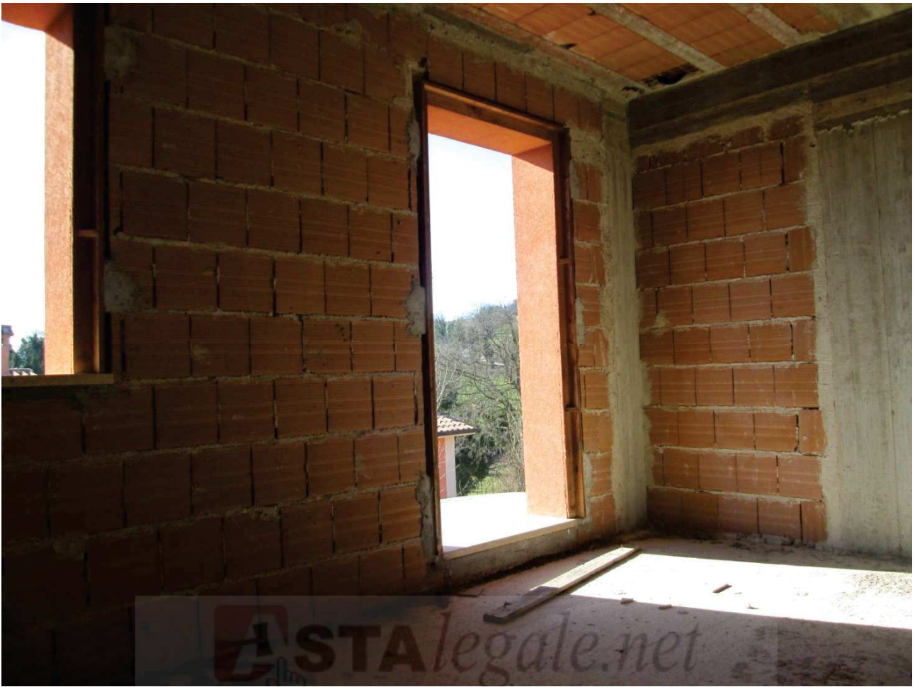
Interno piano primo
