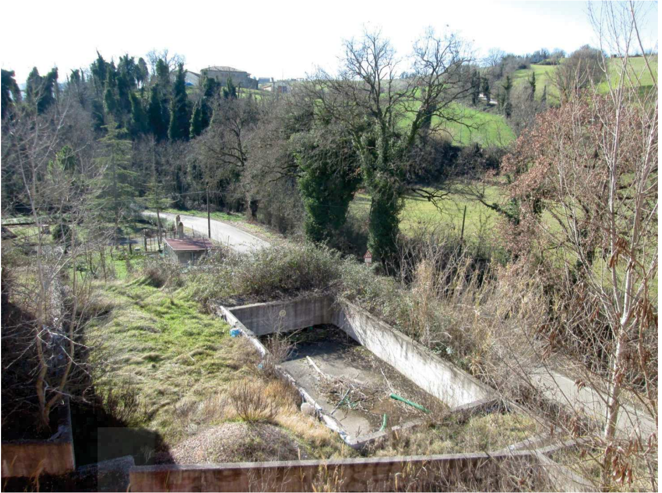
Vista dall'alto della vasca per futura piscina
