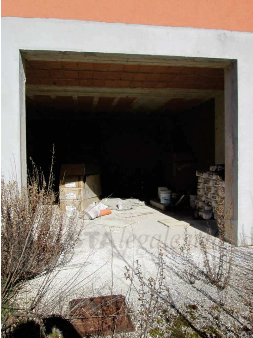
Vista dell'interno di garage
