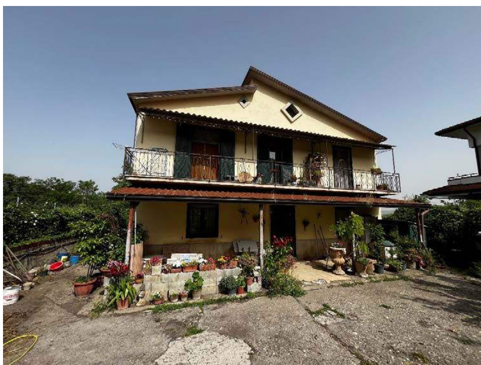
Foto n. 4: veduta del prospetto frontale del fabbricato
