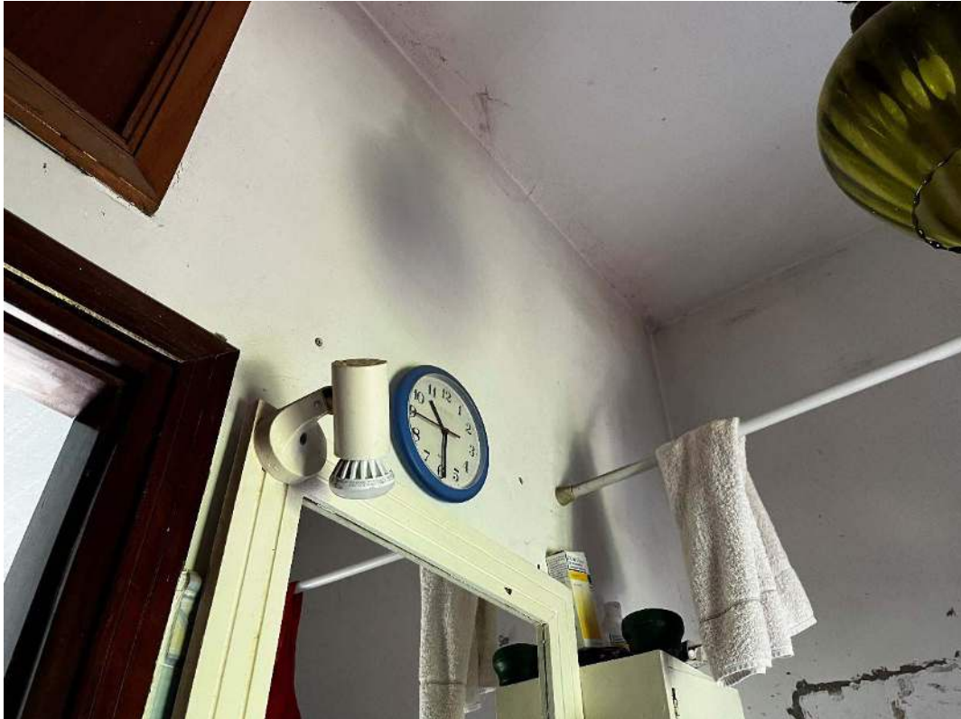
Foto n. 15: vano w.c. in corrispondenza del vano scala
