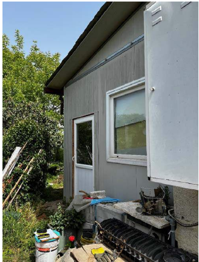
Foto n. 7: Accesso ai locali deposito sul lato posteriore del fabbricato
