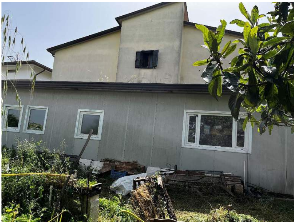
Foto n. 8: Veduta del lato posteriore del fabbricato
