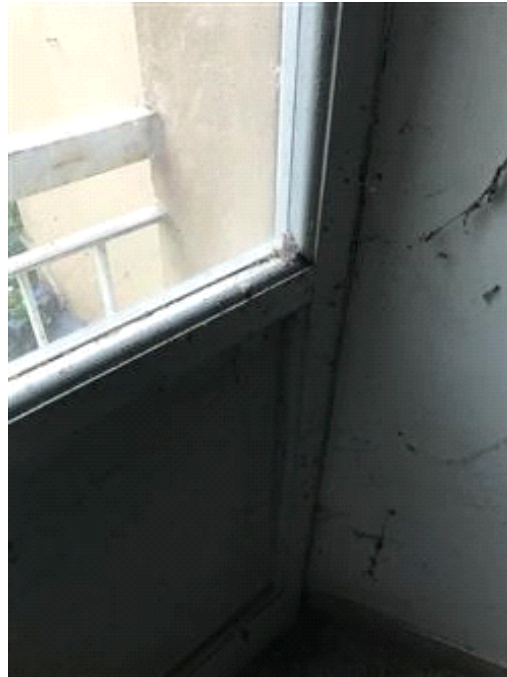
Infissi esterni laddove presenti
