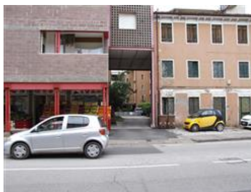
Particolare dell'accesso carroia da via Medici
