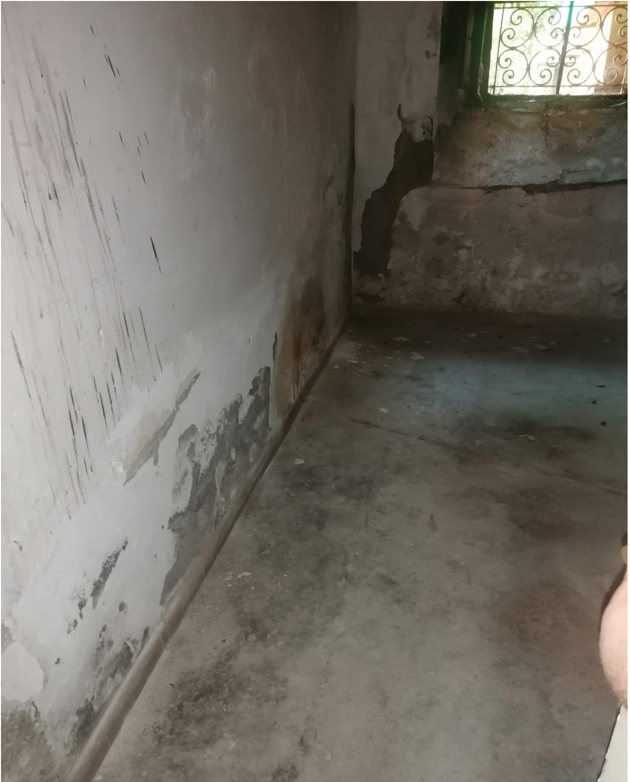
Deposito piano seminterrato
