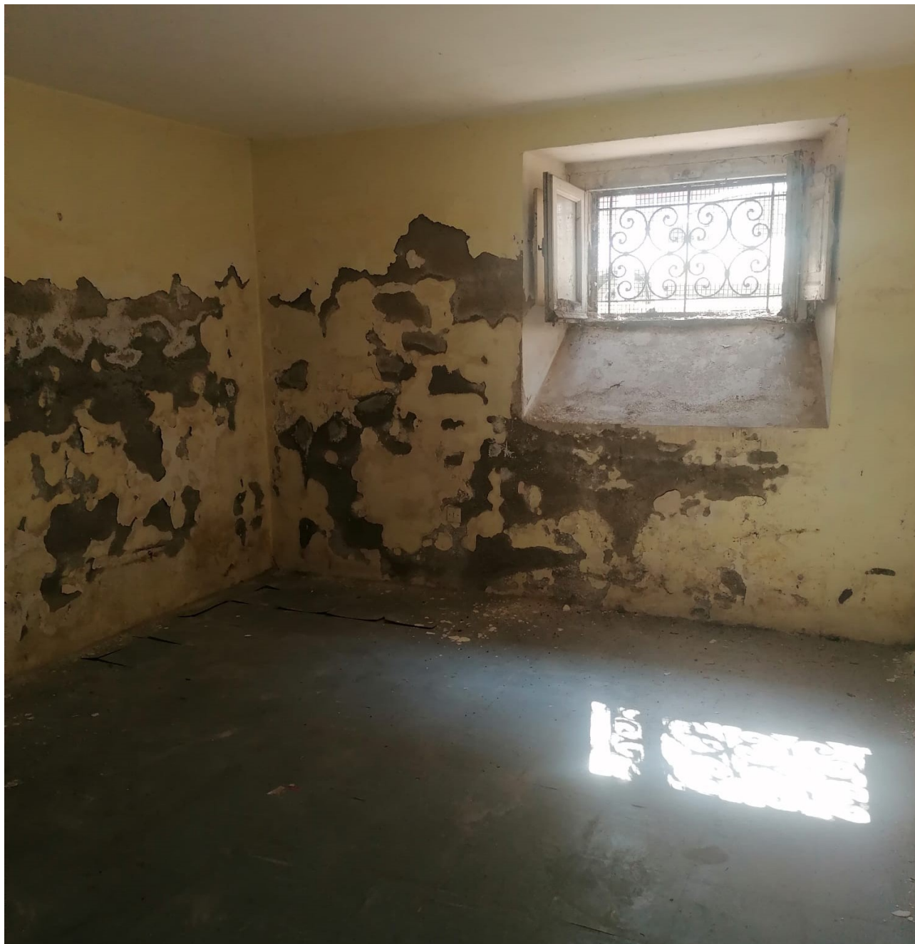
Deposito piano seminterrato
