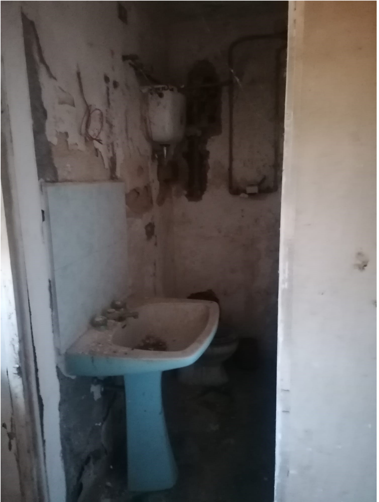
Deposito piano seminterrato
