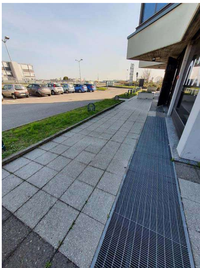
RILIEVO ESTERNO – Sub. 715 – Foto 7 e 8. Viste degli spazi esterni prospicienti il Negozio (sala da ballo).
