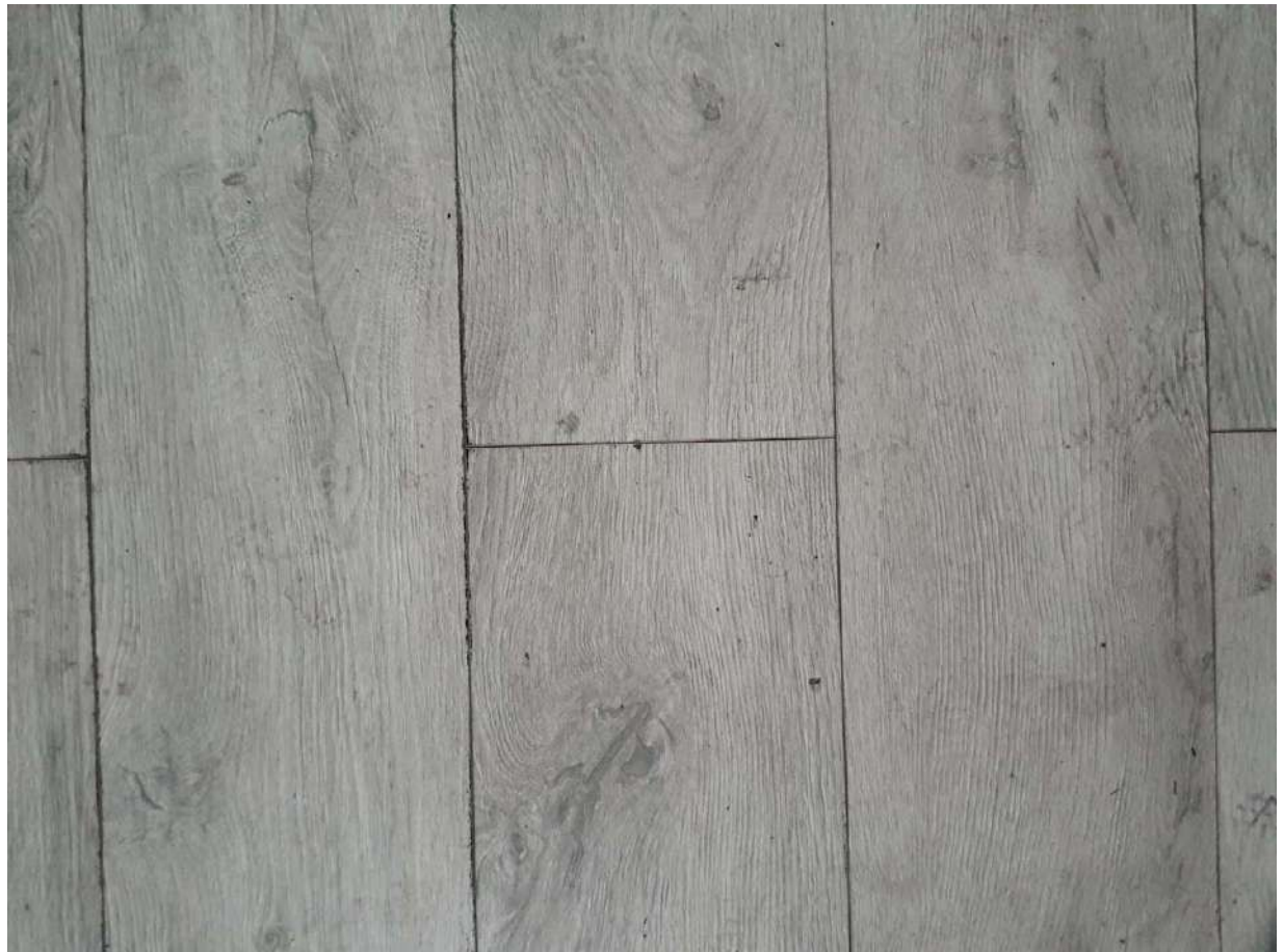
RILIEVO PARTICOLARI – Sub. 715 – Foto 90-92. Dettagli delle pavimentazioni e rivestimenti presenti nei locali di servizio e nella sala da ballo.
