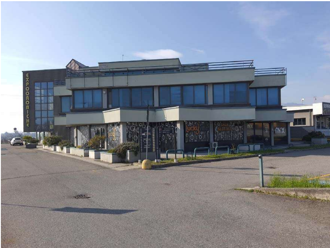
RILIEVO ESTERNO - Sub. 715 – Foto 1 e 2 . Viste del fabbricato a destinazione terziaria/servizi al n. 10/A di Via Dalmine.
