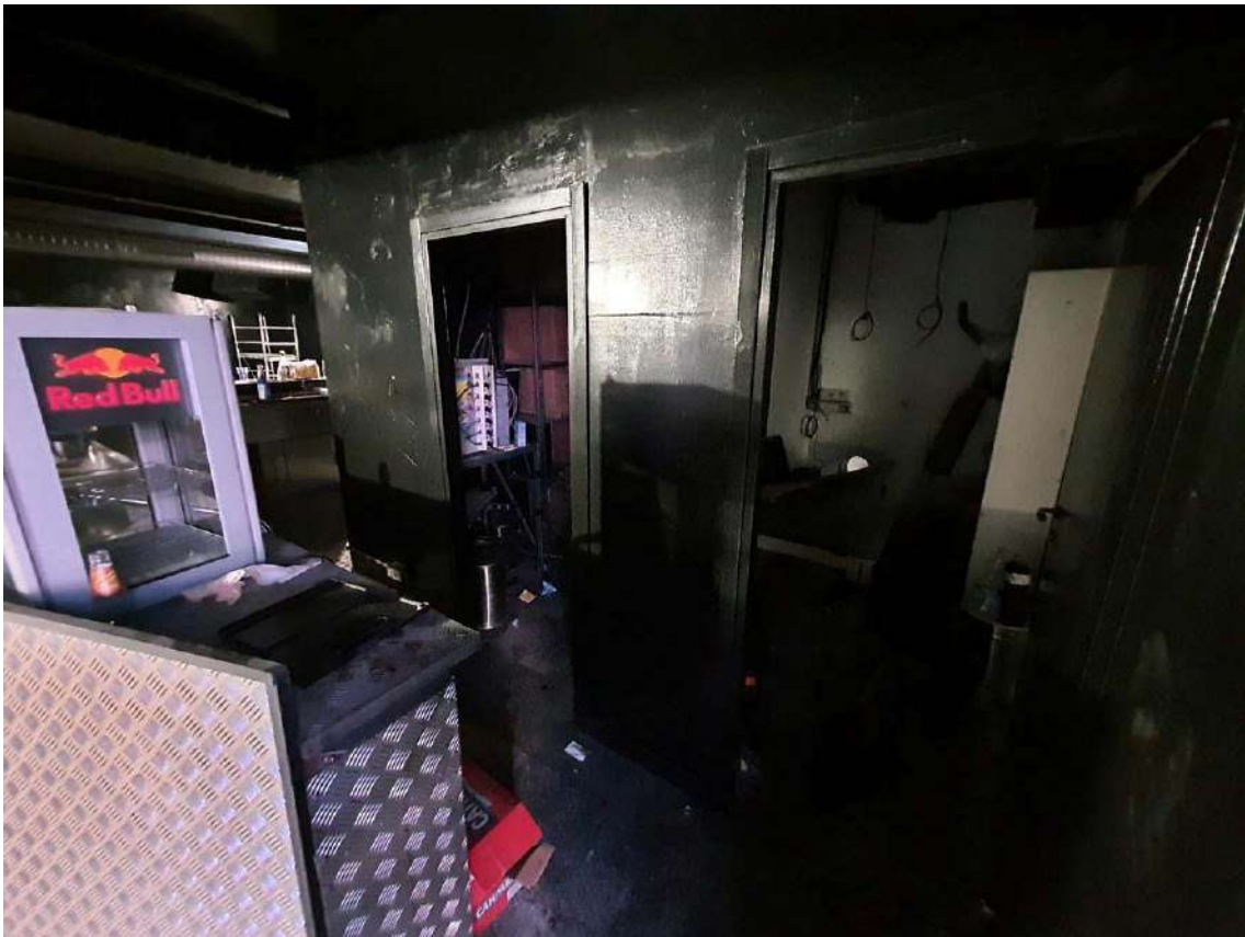
RILIEVO INTERNO – Sub. 715 – Foto 48 e 49. Riprese della zona retro banco Bar e degli ingressi al Vano Pluri-uso (a dx) e Magazzino scorte.
