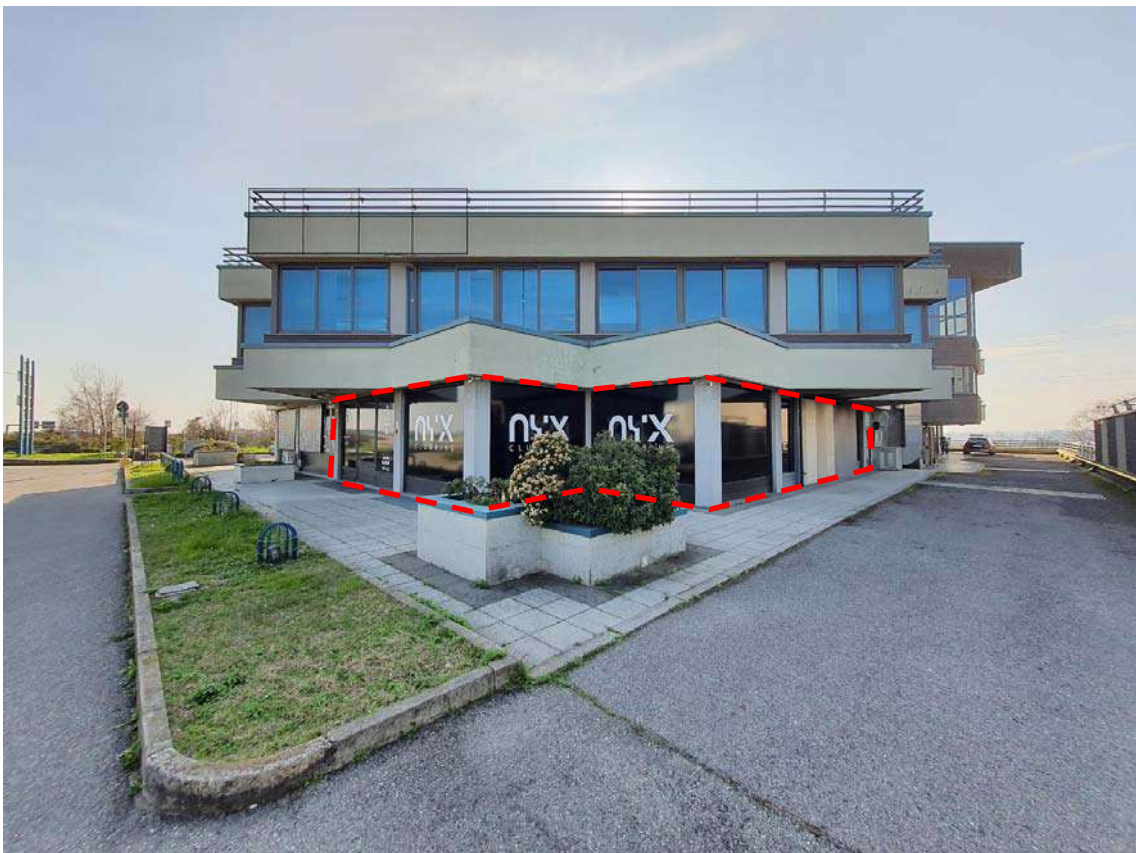
RILIEVO ESTERNO – Sub. 715 – Foto 3 e 4. Identificazione del Negozio (sala da ballo) soggetto ad esecuzione al Piano Terra del fabbricato.
