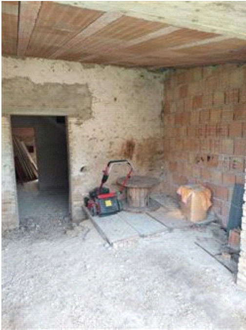
Ingresso dalla loggia al PT
