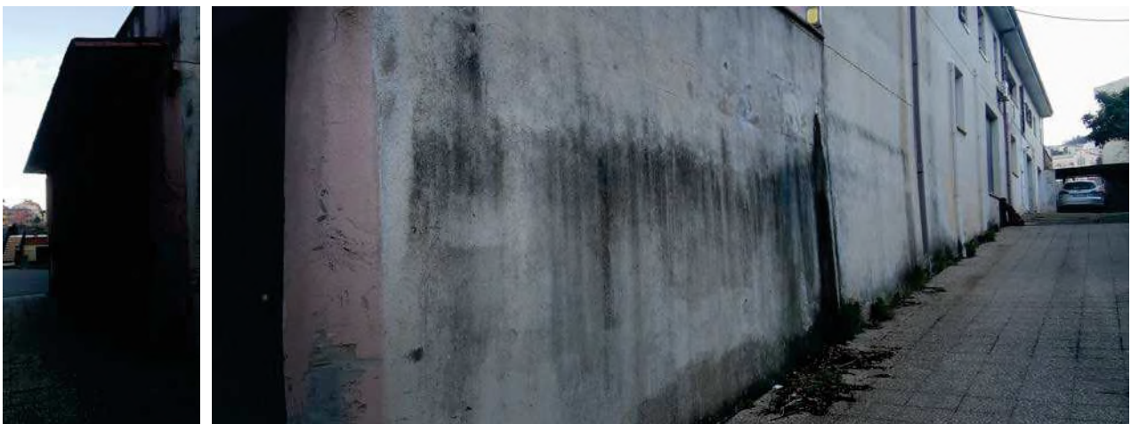
Immagine 42 - 46: Immagini degli esterni lato Ovest (a monte)
