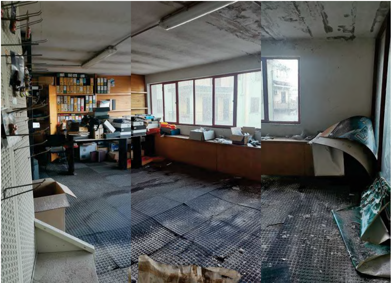
Immagine 21 - 23 : Interni del locale a piano primo (soppalco) con i particolari della zona con il solaio non transitabile.
