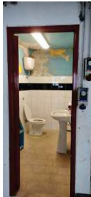
Immagine 18 -20: Interni del locale a piano primo (soppalco) con i particolari della zona con il solaio in acciaio transitabile, del bagno e dell'altro soppalco.
