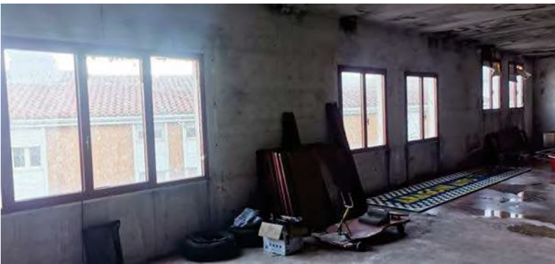
Immagine 31 - 36: Interni del locale a piano secondo
