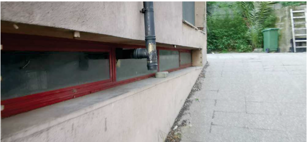
Immagine 49 : Immagini degli esterni lato nord
