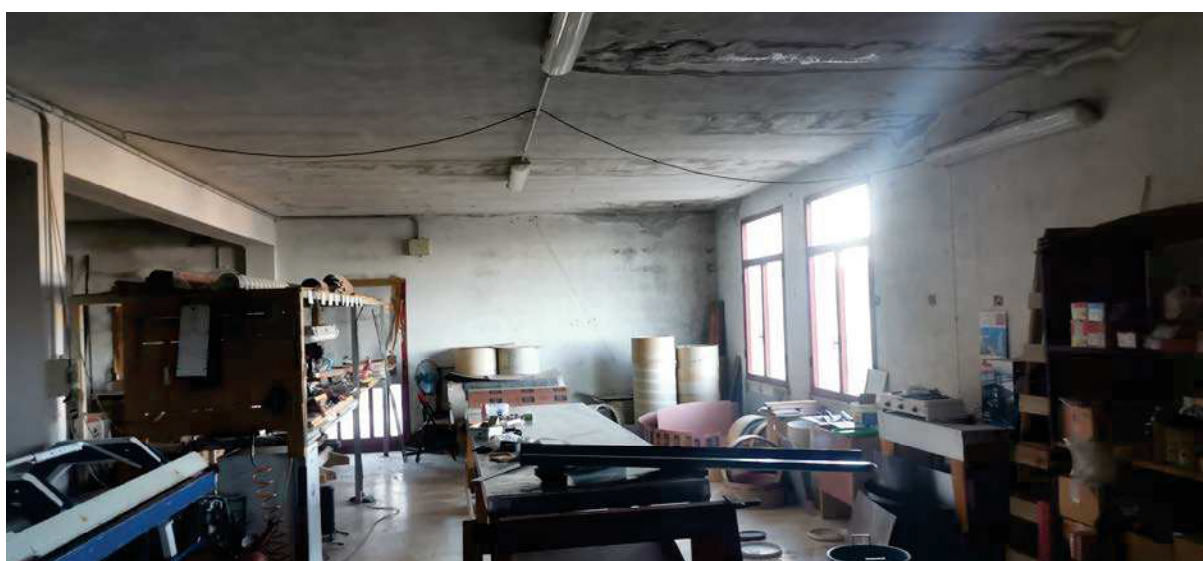
Immagine 25 - 27: Interni del locale a piano secondo
