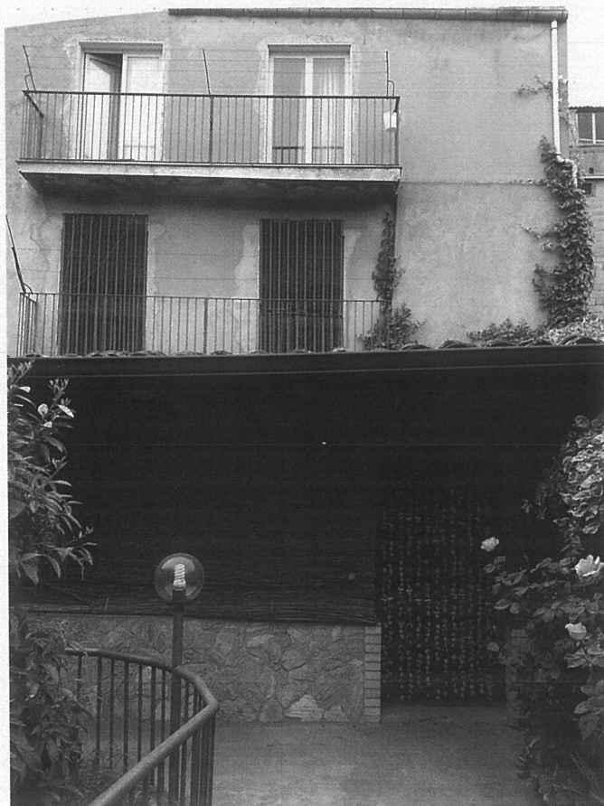
VISTA ESTERNA - LATO EST
