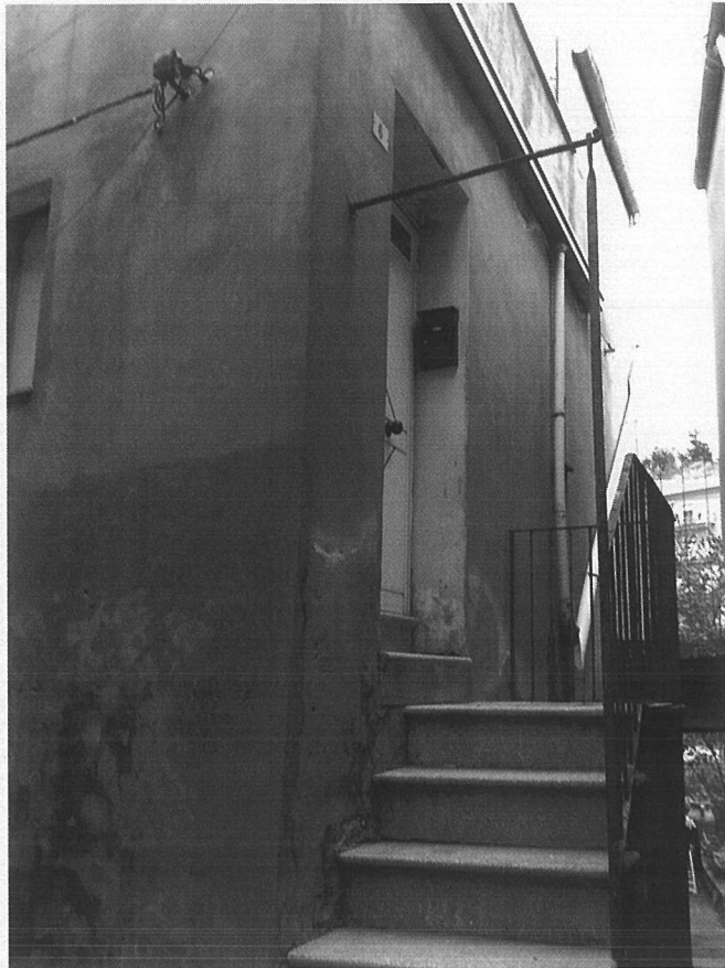
VISTA ESTERNA-LATO INGRESSO CORTILE LA PORTA 6
