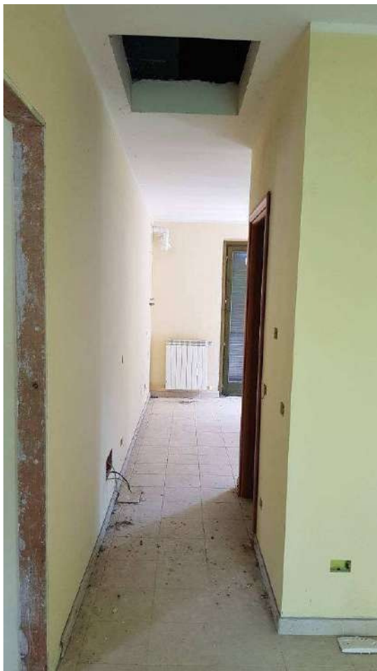
FOTO 18 - INTERNO APPARTAMENTO B4
