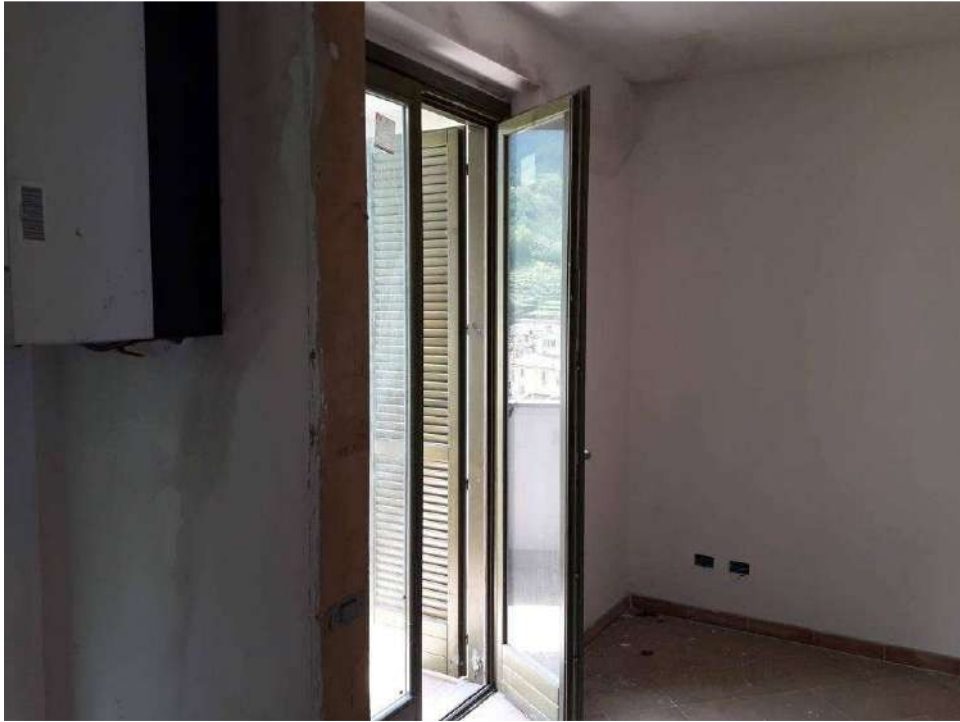
FOTO 19 - INTERNO APPARTAMENTO B5
