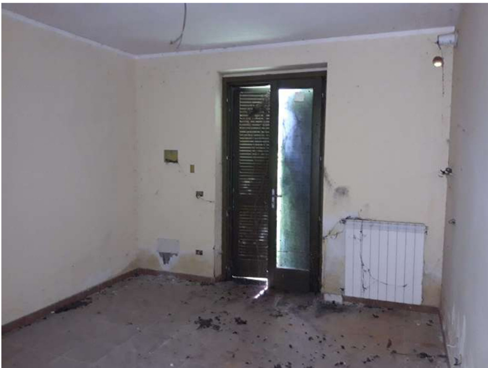
FOTO 16 - INTERNO APPARTAMENTO B3
