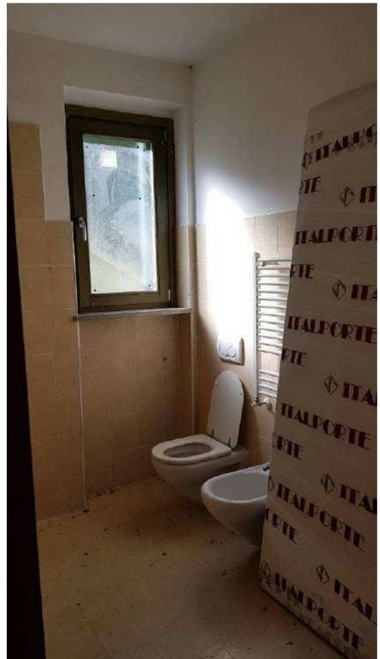
FOTO 4 - INTERNO APPARTAMENTO A1
