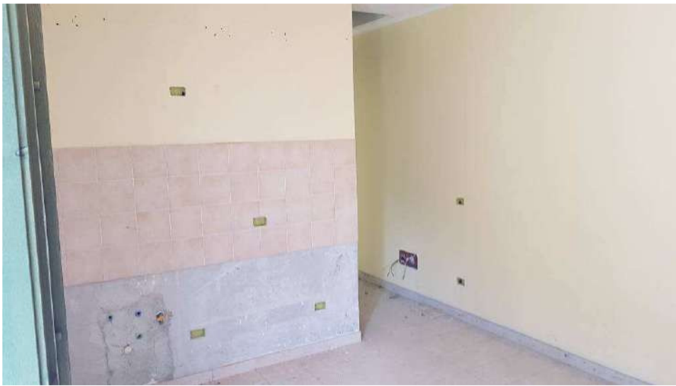
FOTO 17 - INTERNO APPARTAMENTO B4
