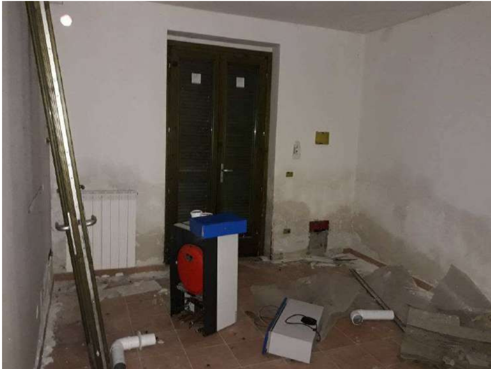
FOTO 11 - INTERNO APPARTAMENTO B1
