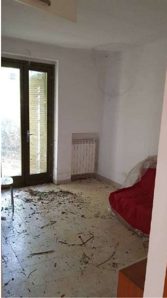
FOTO 3 - INTERNO APPARTAMENTO A1
