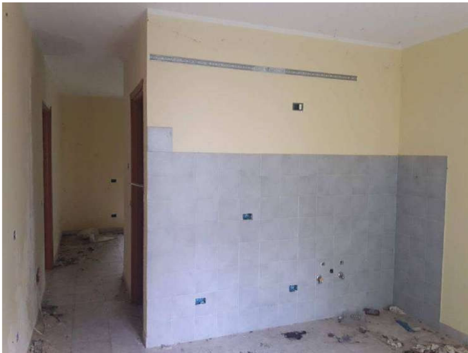
FOTO 22 - INTERNO APPARTAMENTO C1
