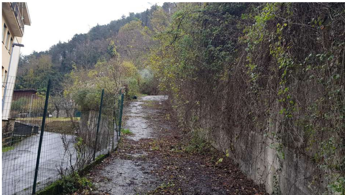
FOTO 1 - PARTI COMUNI - RAMPA DI ACCESSO
