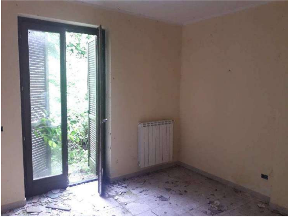
FOTO 21 - INTERNO APPARTAMENTO C1
