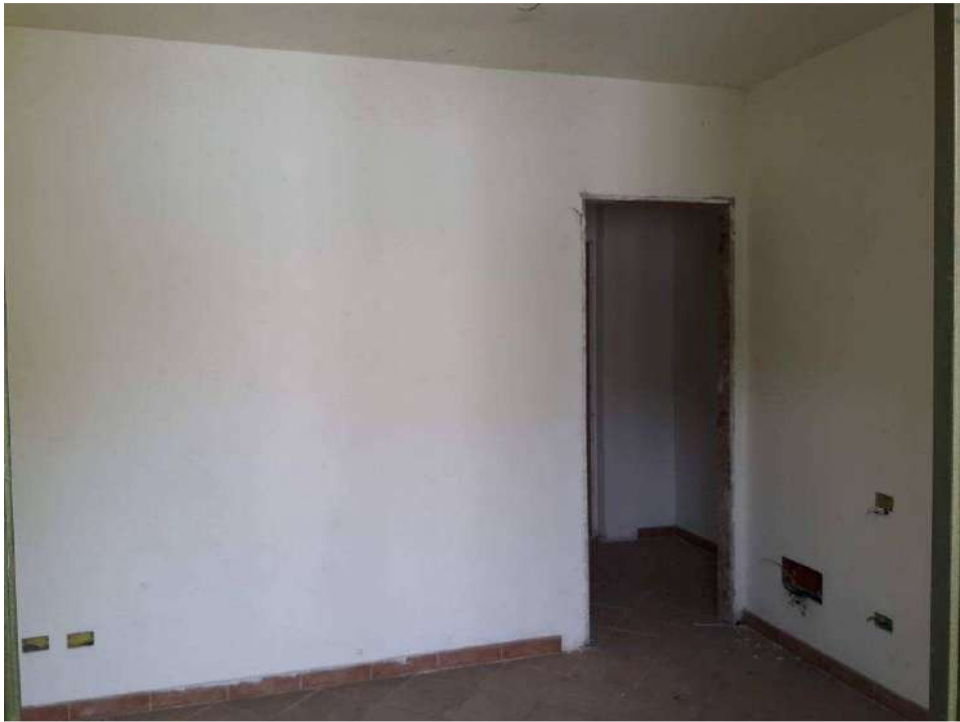
FOTO 20 - INTERNO APPARTAMENTO B5
