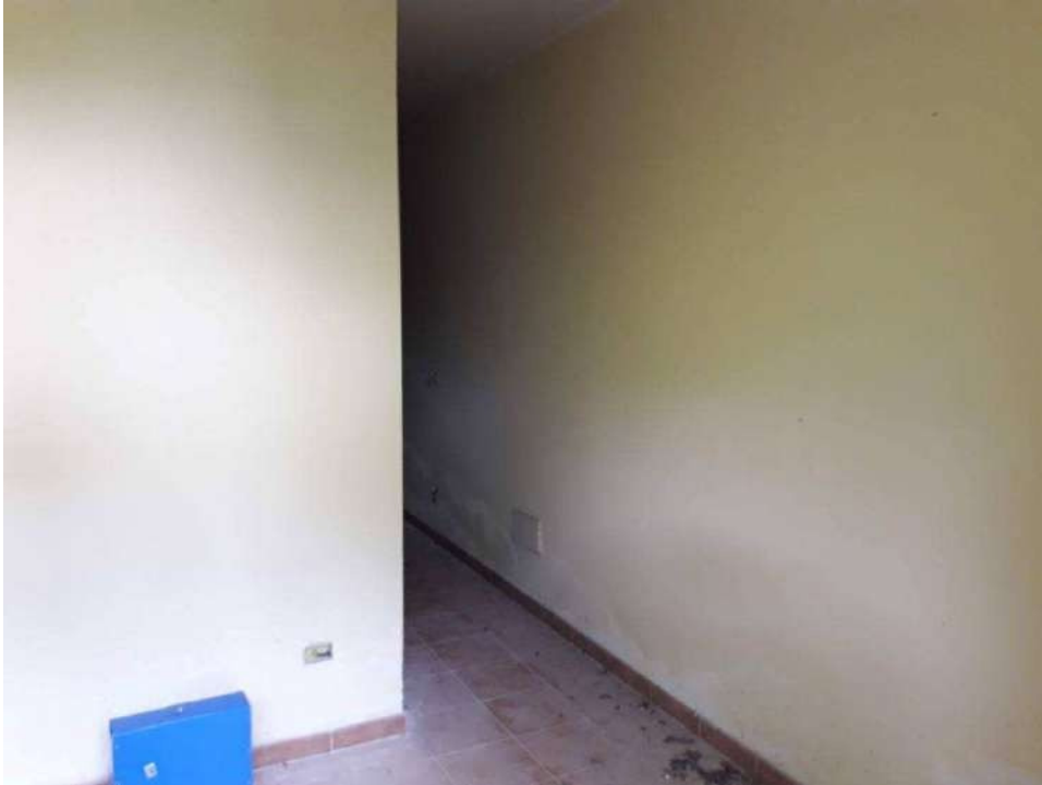
FOTO 15 - INTERNO APPARTAMENTO B3
