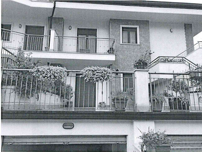
Foto n. 5: Vista terrazzo n. 2
