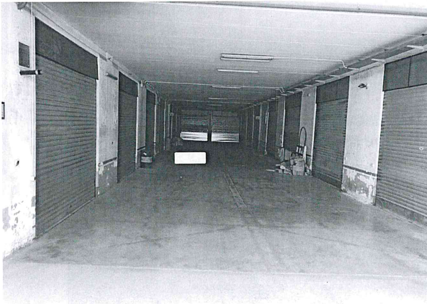
Foto n. 4: Area di manovra piano seminterrato
