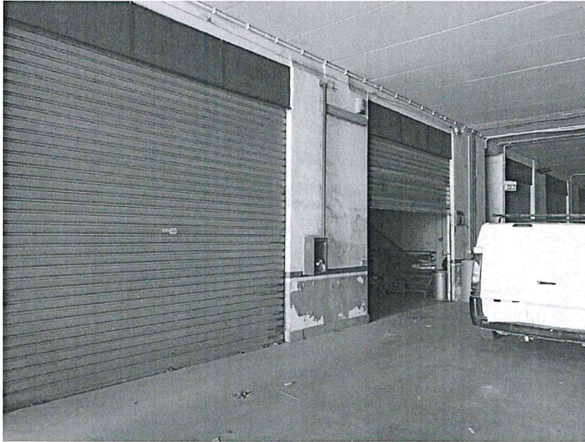
Foto n. 5: Ingresso box – sub. 23 – 24
