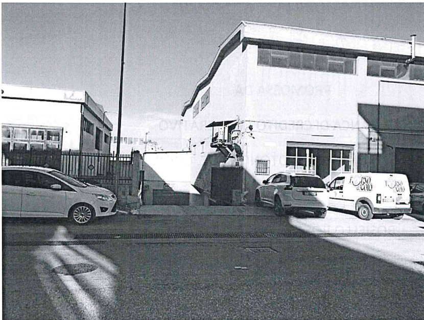
Foto n. 2: Ingresso piano seminterrato – viale della Gioventù
