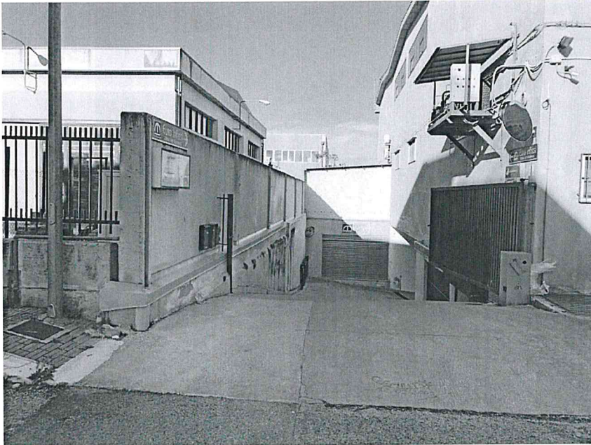
Foto n. 3: Ingresso piano seminterrato – viale della Gioventù
