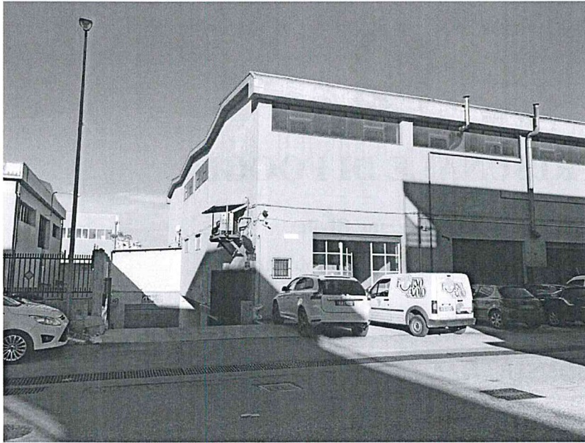
Foto n. 1: Ingresso piano seminterrato – viale della Gioventù
