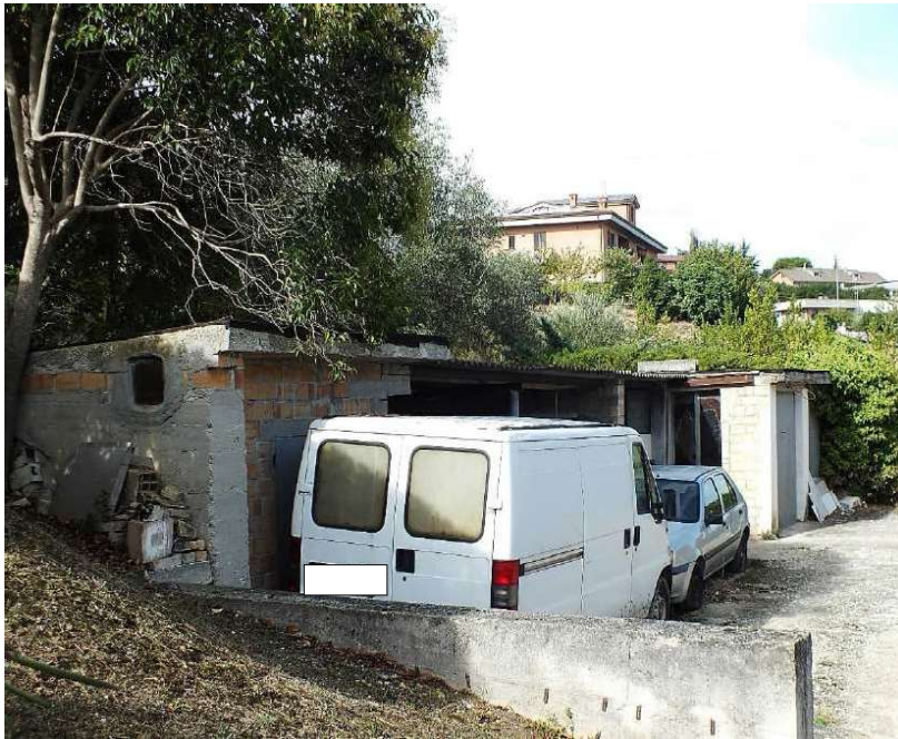
Foto 53 Immobile 1b Lato Nord facciata principale
