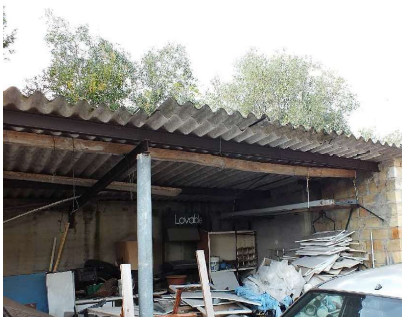
Foto 50 Immobile 1b Lato Nord facciata principale
