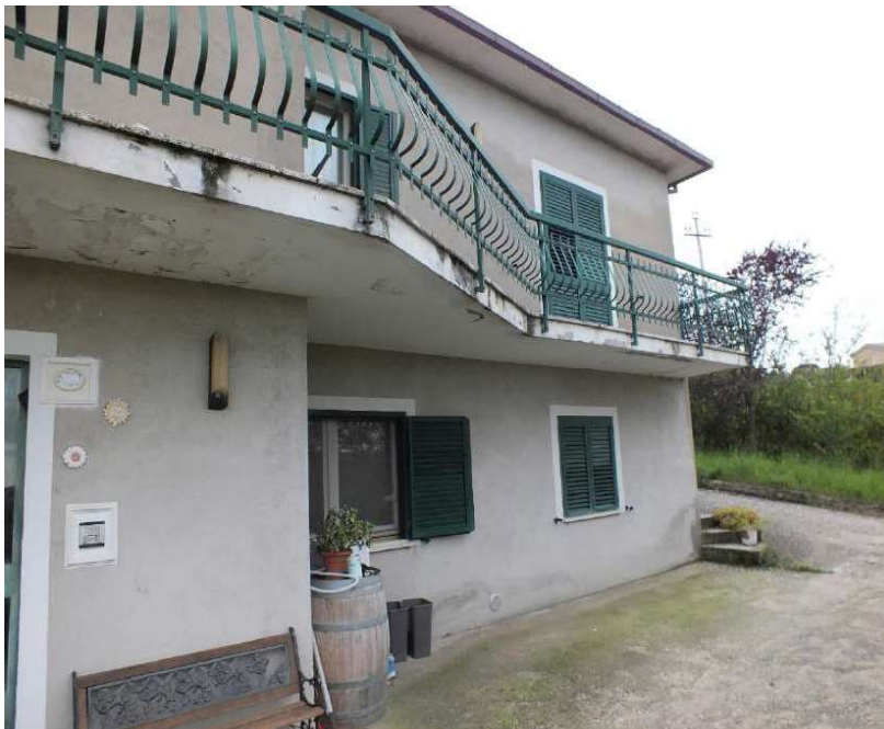
Foto 34 Immobile 1a Lato Nord facciata principale
