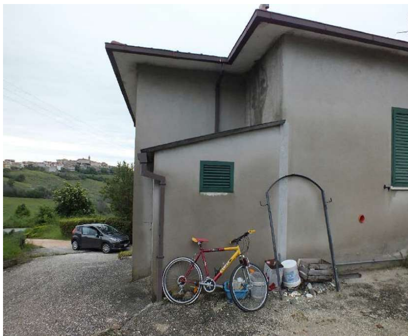
Foto 40 Immobile 1a Lato Sud
