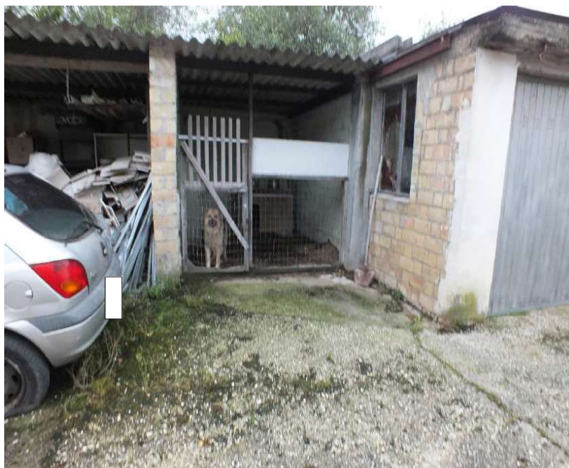
Foto 49 Immobile 1b Lato Nord facciata principale
