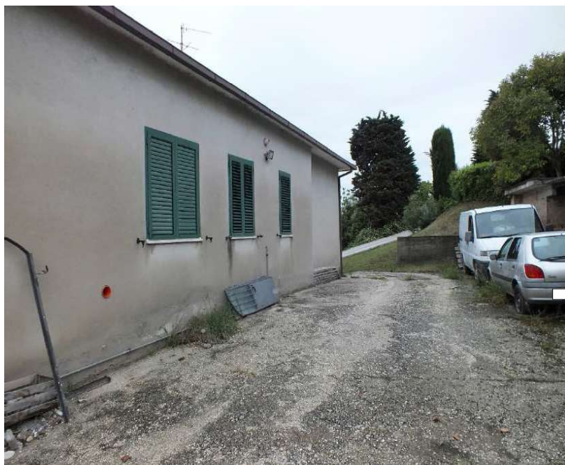
Foto 39 Immobile 1a Lato Sud
