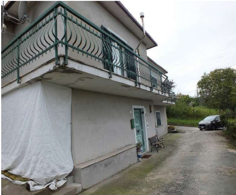
Foto 33 Immobile 1a Lato Nord facciata principale
