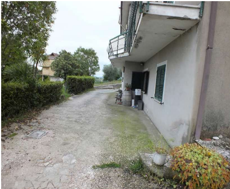
Foto 32 Immobile 1a Lato Nord facciata principale
