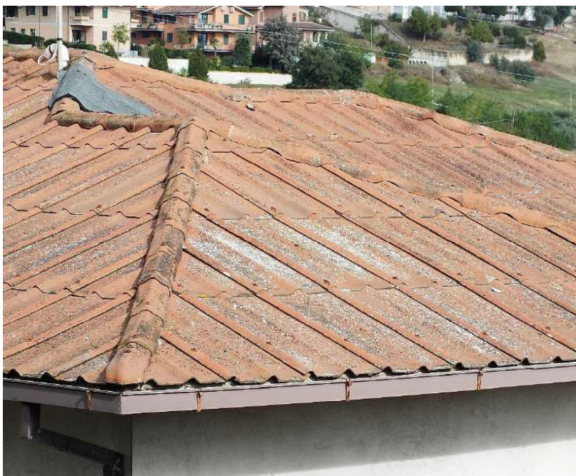
Foto 46 Immobile 1a Particolare Tetto
