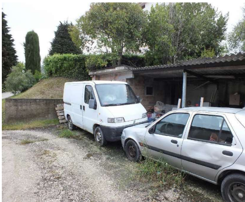
Foto 52 Immobile 1b Lato Nord facciata principale
