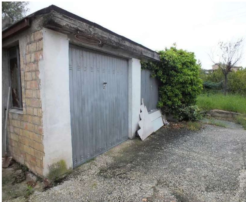
Foto 48 Immobile 1b Lato Nord facciata principale
