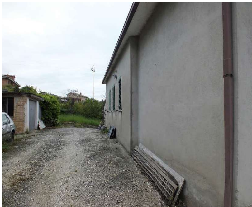
Foto 38 Immobile 1a Lato Sud
