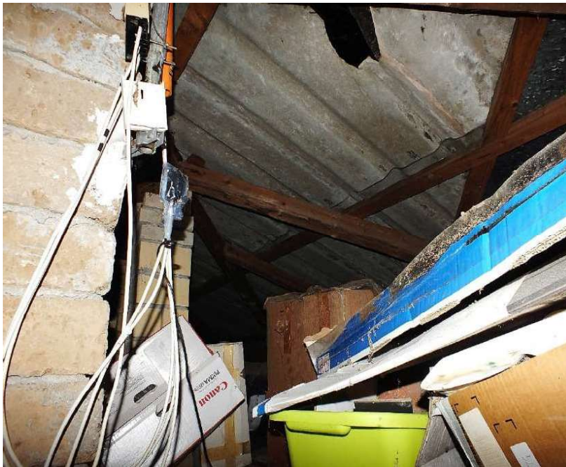
Foto 28 Immobile 1a Piano Primo o Sottotetto – soffitta
