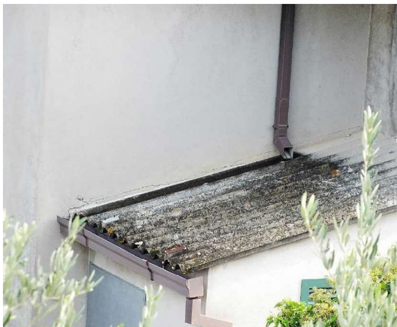
Foto 47 Immobile 1a Vista da lontano - ripostiglio
