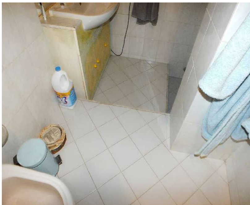
Foto 11 Immobile 1a Piano Seminterrato – bagno
