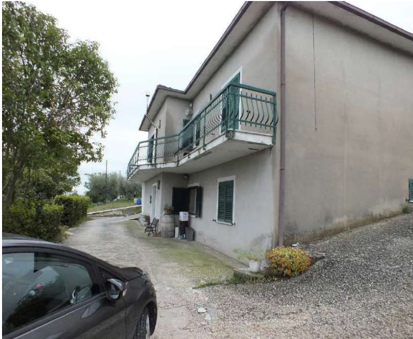
Foto 31 Immobile 1a Lato Nord facciata principale
