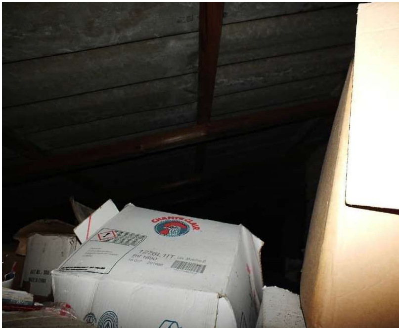
Foto 30 Immobile 1a Piano Primo o Sottotetto – soffitta
