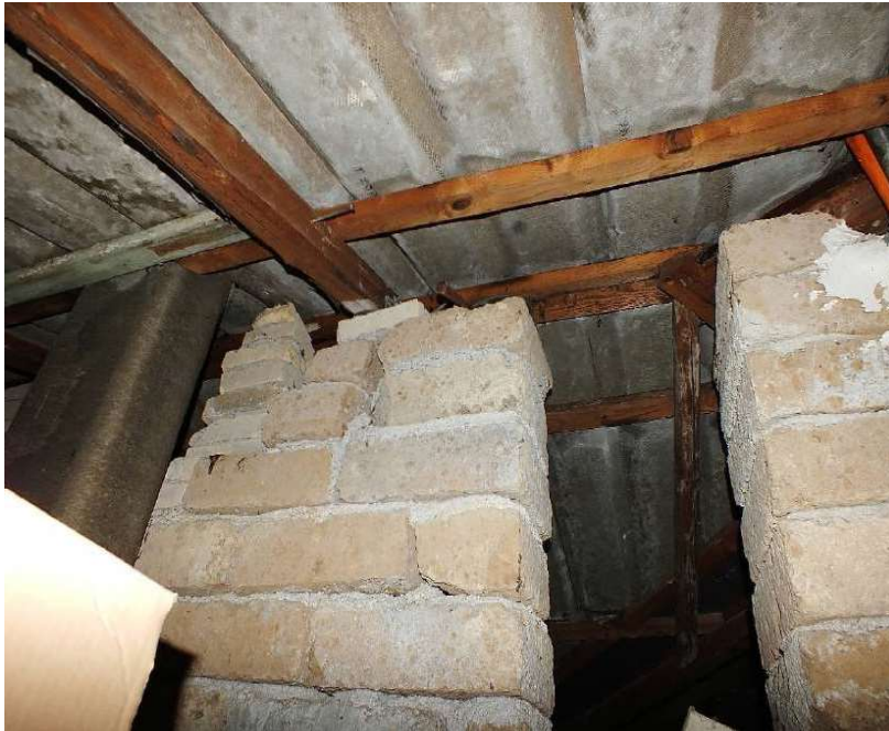
Foto 29 Immobile 1a Piano Primo o Sottotetto – soffitta
