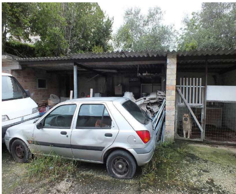
Foto 51 Immobile 1b Lato Nord facciata principale
