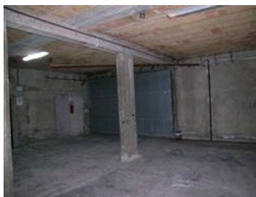
Garage comune piano interrato
