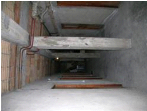
Corridoio comune piano interrato
