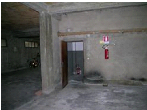
Garage comune piano interrato
