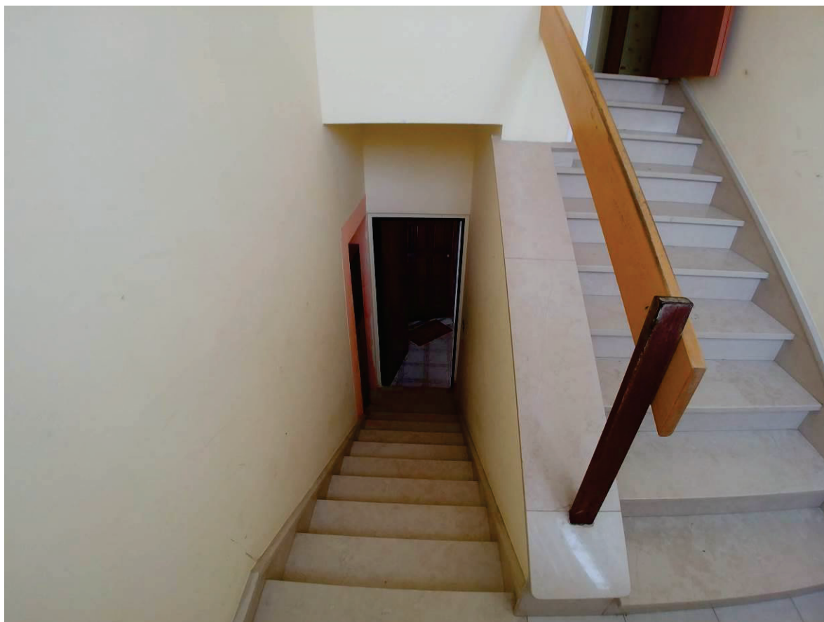
Figura 11: scala interna di accesso al sub 14 da 3 ^ piano
