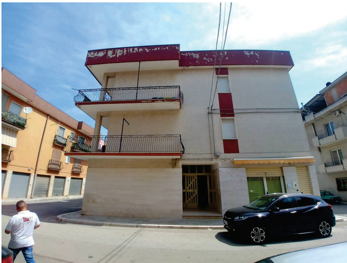
Figura 6: portone condominiale ingresso, via Anzio 15
