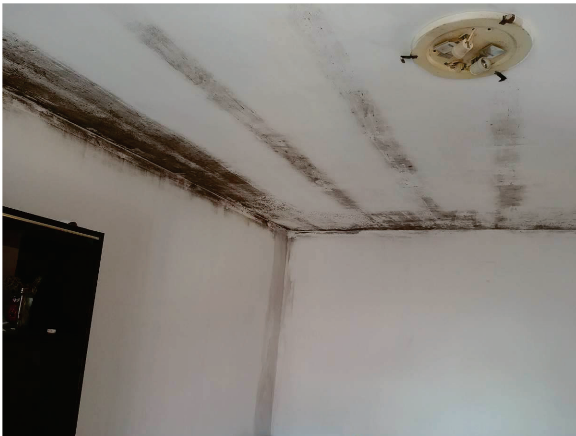
Figura 19: interno immobile con destinazione d'uso vani tecnici da C.E. 7304/87 (adibiti ad appartamento)
