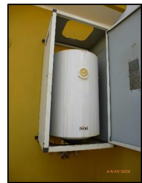
Caldaia a metano P. 2°
