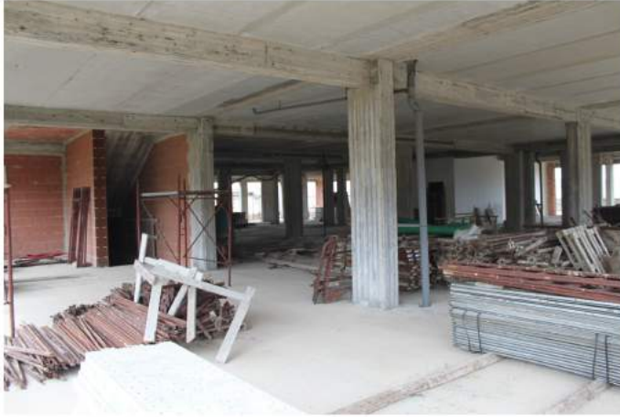
EDIFICIO A FOTO 4
