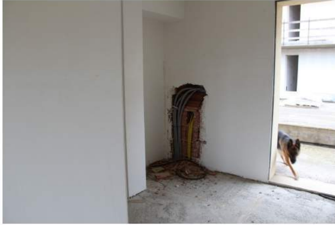
EDIFICIO A FOTO 7
