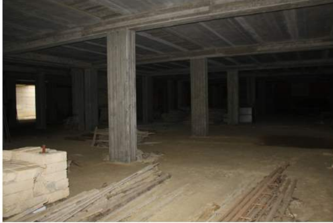
EDIFICIO A FOTO 1
