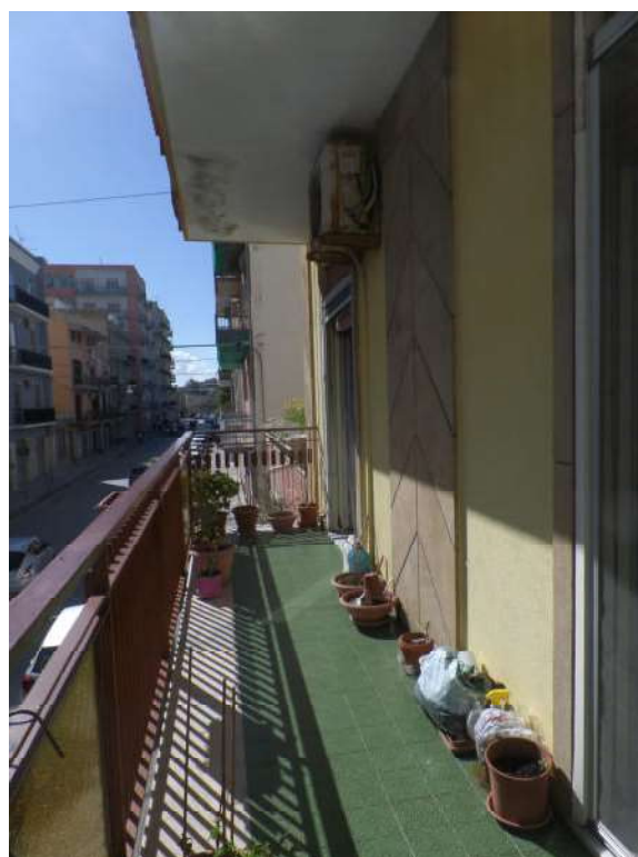
Foto n° 11. Balcone su Via G. Lavaggi
