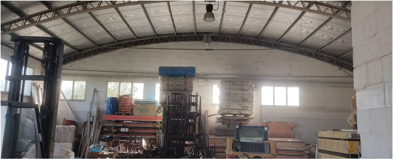
Vista interna del capannone Foto n.7
