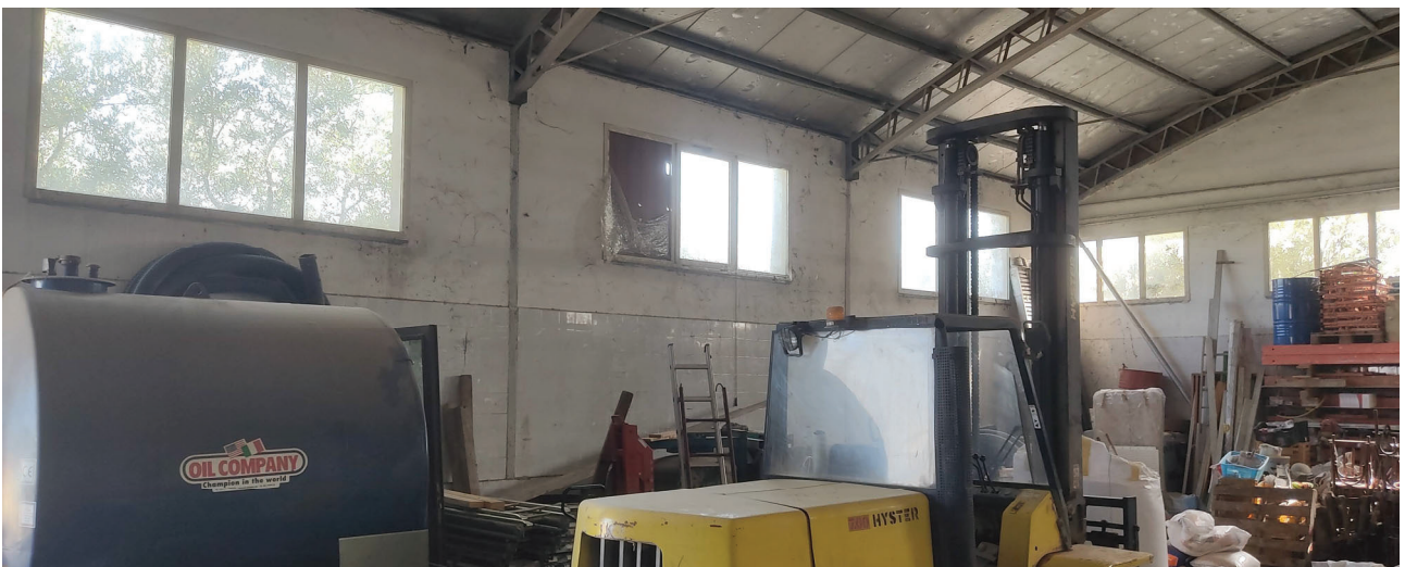
Vista interna del capannone Foto n.9
