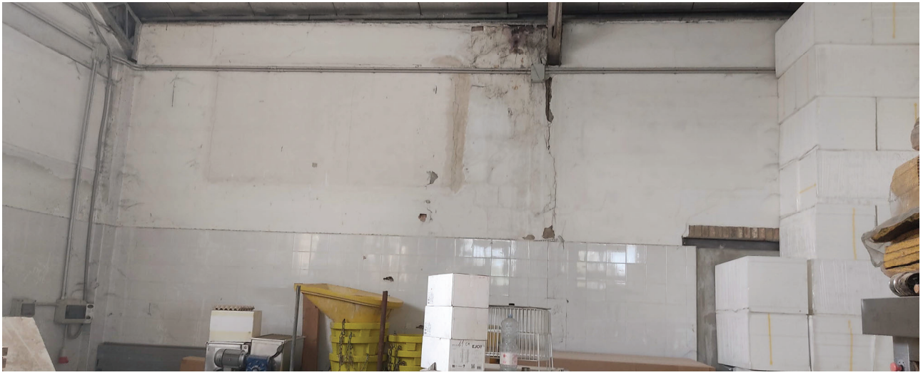
Vista interna del capannone Foto n.10
