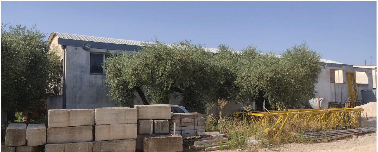
Vista esterna del capannone Foto n.5
