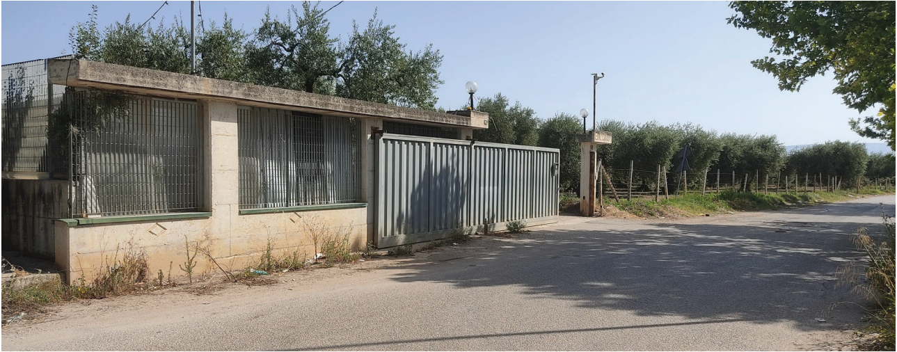
Ingresso su via Tanaro Foto n.1
