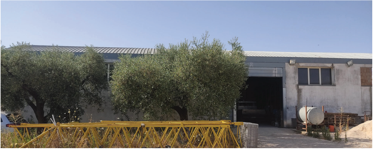
Ingresso del capannone Foto n.4
