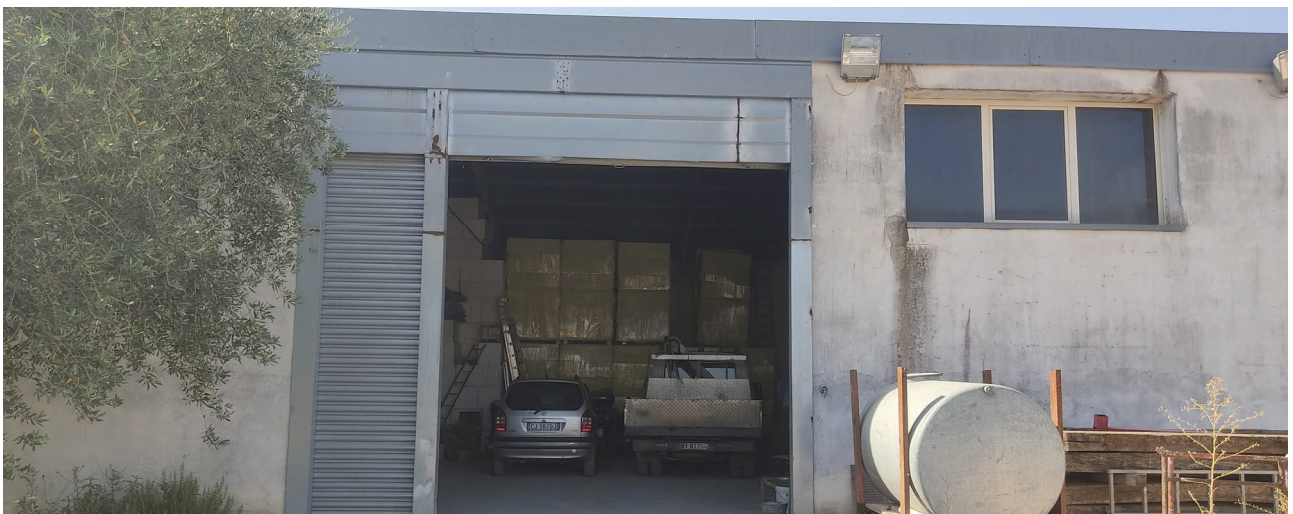
Ingresso del capannone Foto n.6
