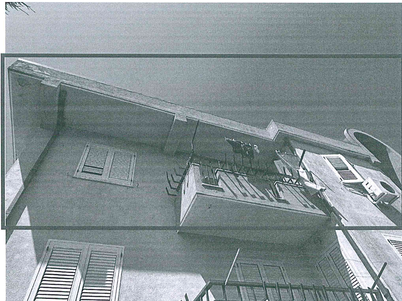
Foto n. 3 – Facciata Nord/Est – Sub. 9
