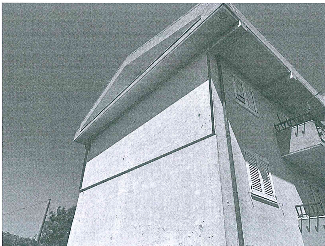
Foto n. 4 – Facciata Sud – Sub. 9
