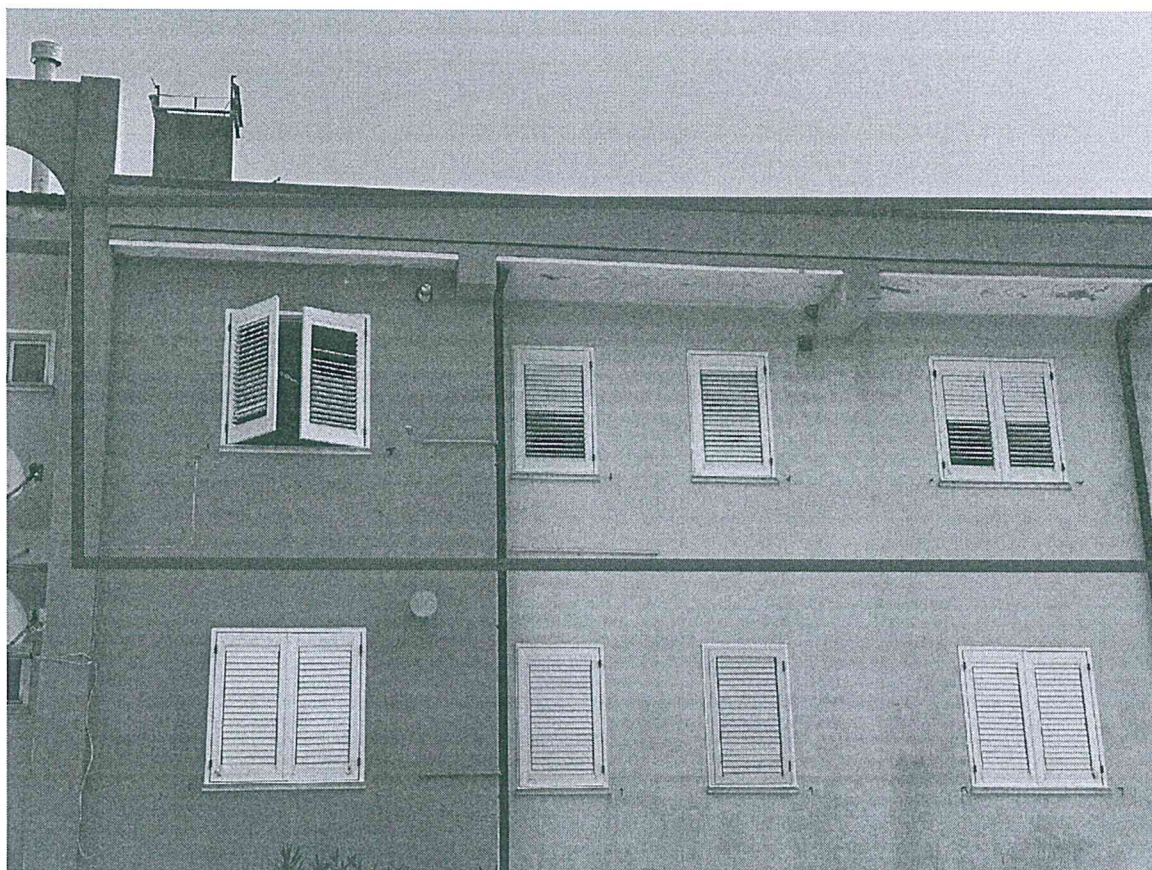
Foto n. 2 – Facciata sud/Ovest – Sub.9
