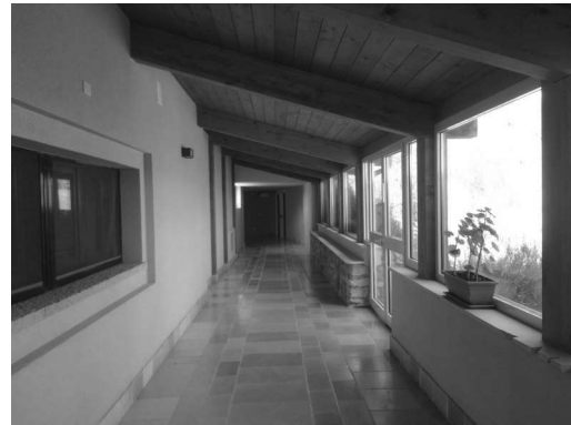
Corridoio di accesso al primo piano (sistema connettivo – tratto "B")
