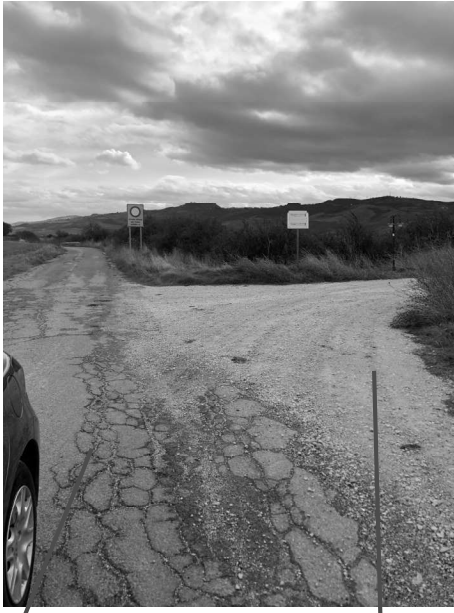
SP 10 – strada privata in massiciata di stabilizzato
