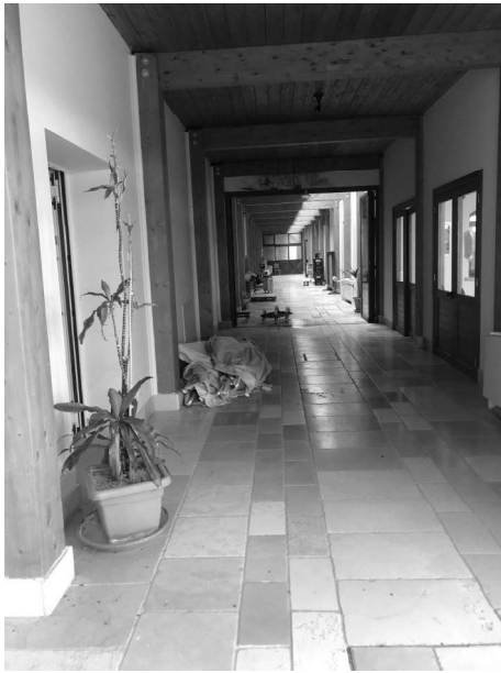
Sistema Connettivo Tratto "B"
