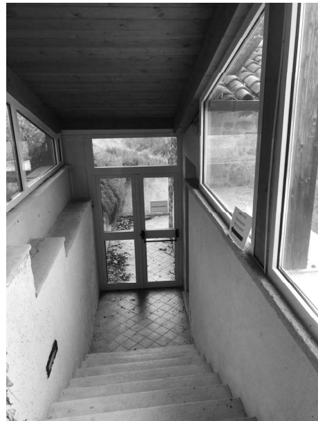
Sistema Connettivo Tratto "B"
