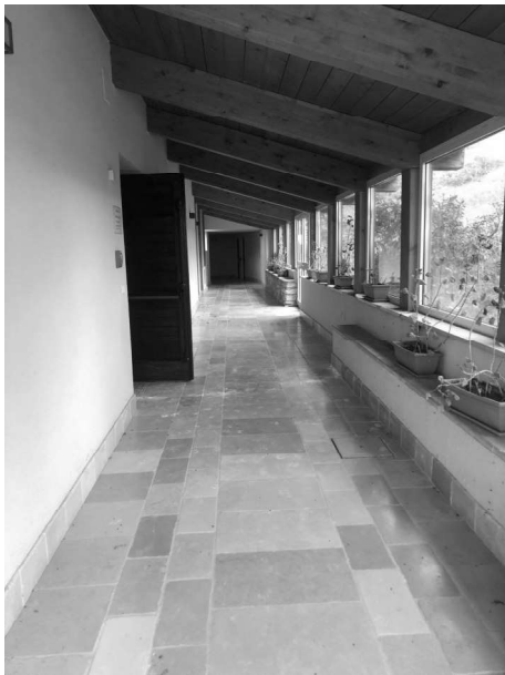
Sistema Connettivo Tratto "B"
