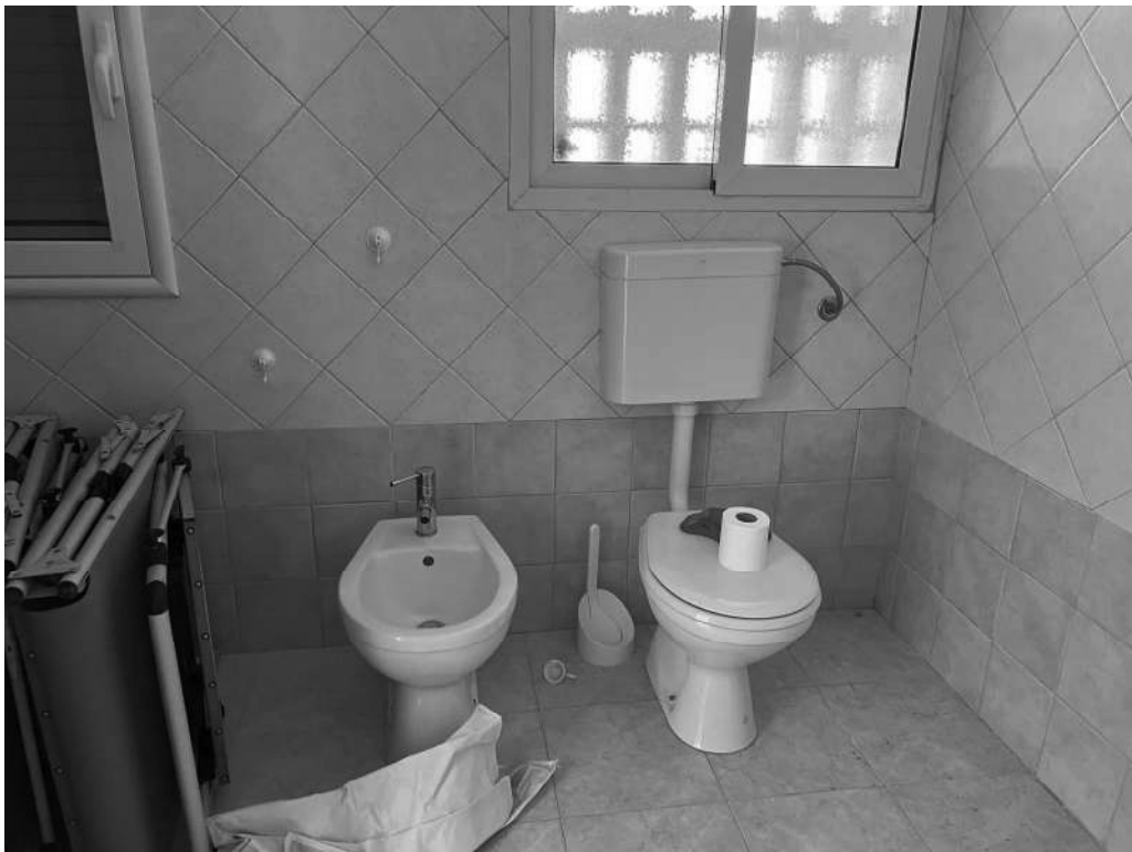
Foto 28. Immobile oggetto di esecuzione, bagno.
