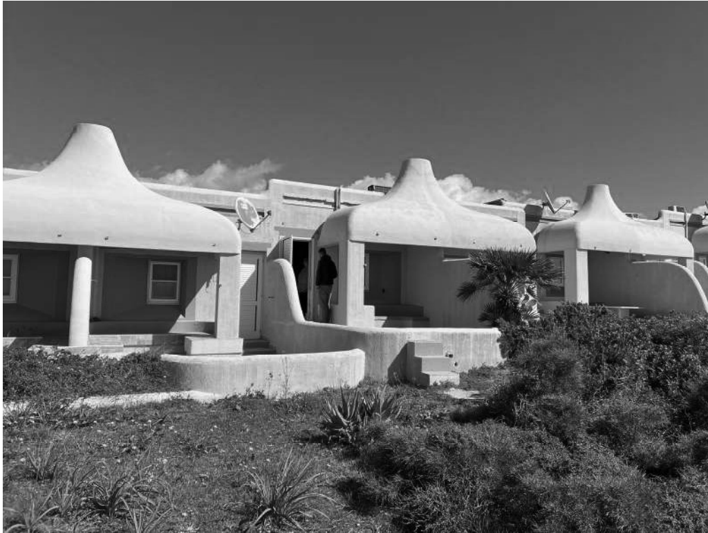
Foto 9. Prospetto lato mare immobile oggetto di esecuzione.
