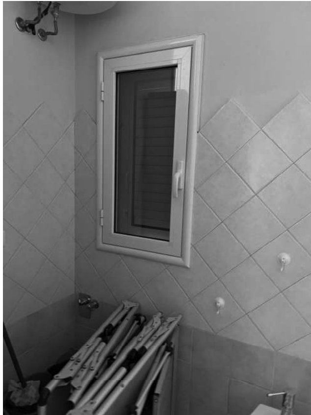
Foto 30. Immobile oggetto di esecuzione, bagno.
