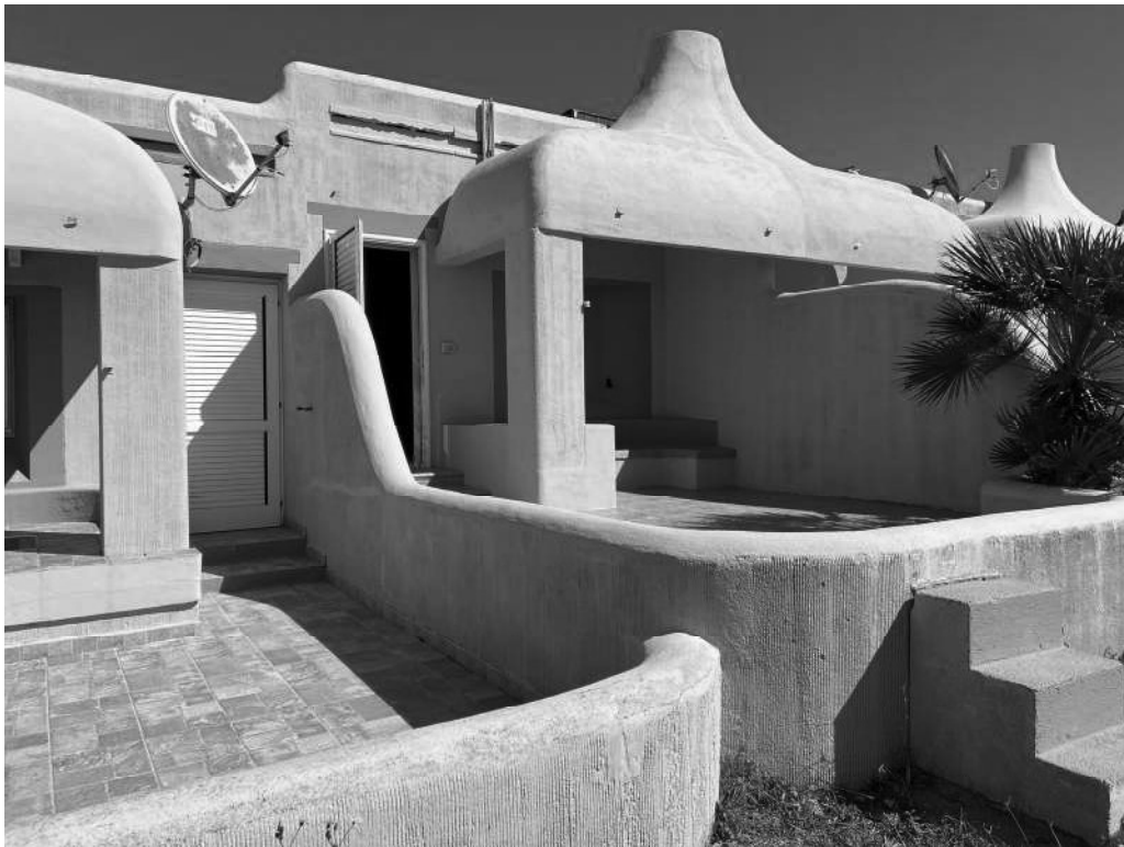
Foto 10. Prospetto lato mare immobile oggetto di esecuzione.
