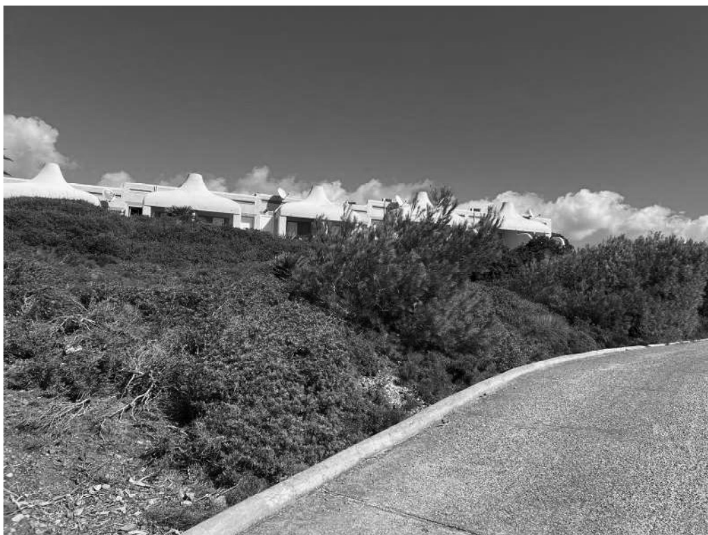
Foto 8. Prospetto lato mare immobile oggetto di esecuzione.
