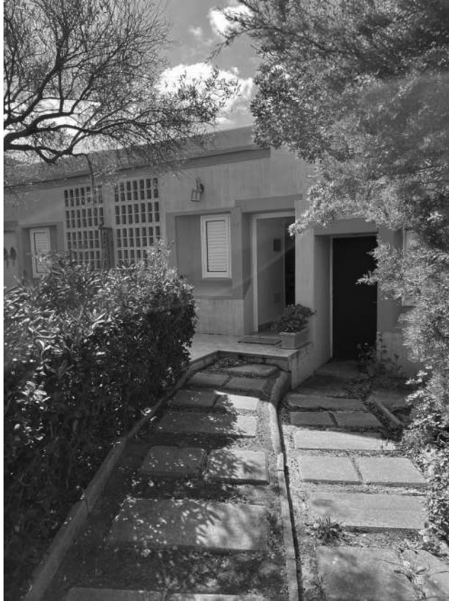
Foto 5. Accesso immobile oggetto di esecuzione.
