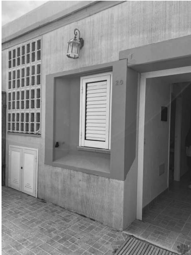
Foto 6. Accesso immobile oggetto di esecuzione.
