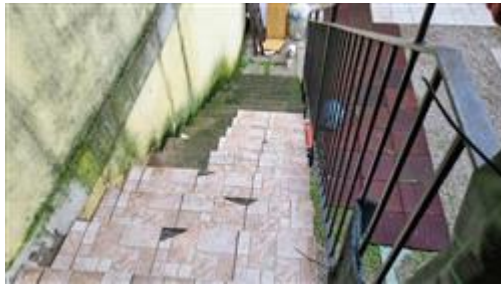
scala di accesso al ballatoio
