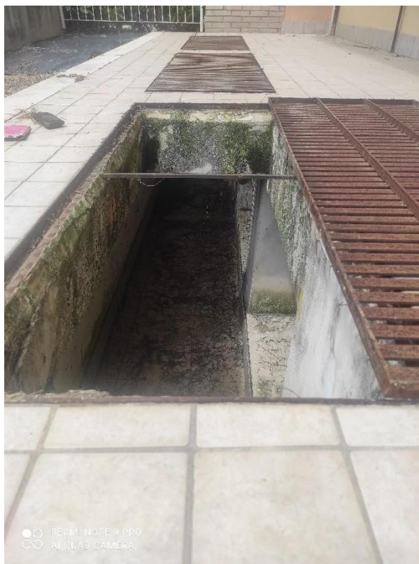
Foto n° 47 – bocche di lupo con infisso di collegamento piano T sub. n. 3 e piano S1 sub. n. 15 – Foto 30.05.2024
