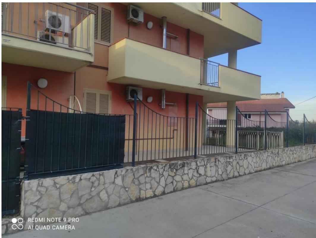
Foto n° 5 – edificio condominiale spigolo Sud-Est – Foto 24.03.2023
