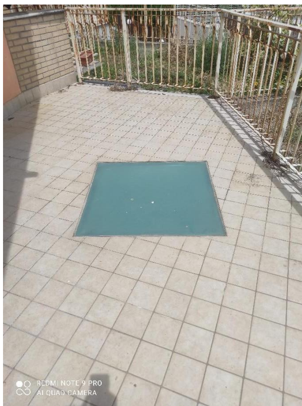
Foto n° 48 – vano per la realizzazione di scala a chiocciola di collegamento tra piano T sub. n. 3 e piano S1 sub. n. 15, vista superiore dell'apertura vetrata atta ad accogliere la prevista scala a chiocciola di collegamento – Foto 30.05.2024
