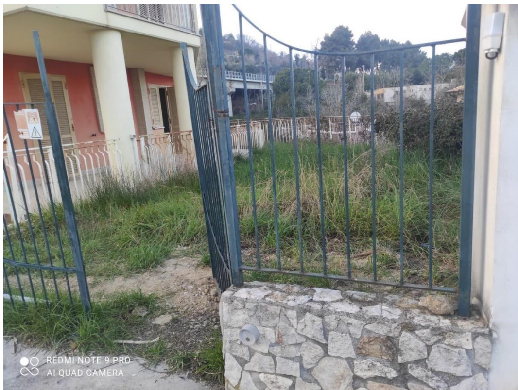
Foto n° 22 – corte esclusiva lato Est appartamento piano terra sub. n. 3 – Foto 24.03.2023
