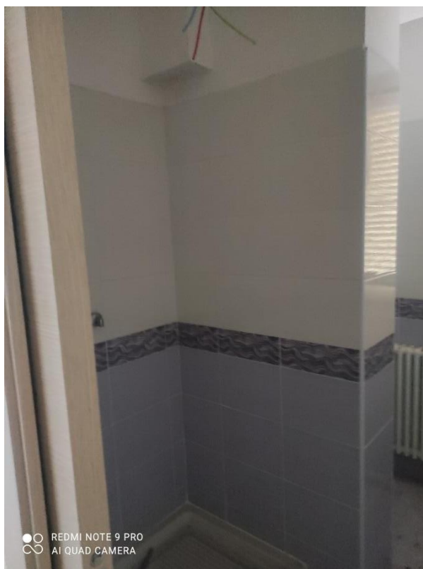
Foto n° 13 – bagno appartamento piano terra sub. n. 3 – Foto 24.03.2023
