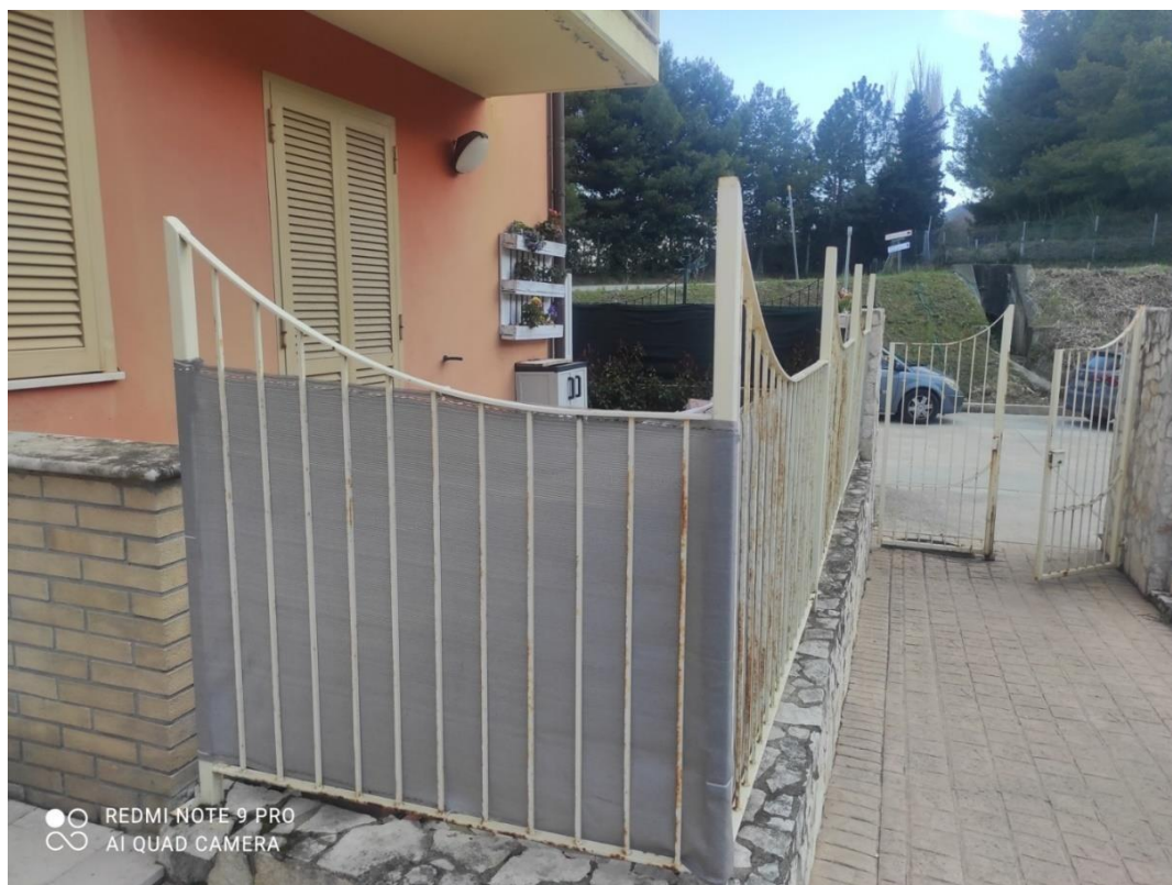
Foto n° 2 – ingresso ad accesso condominiale da via Tre Camini lato Ovest – Foto 24.03.2023
