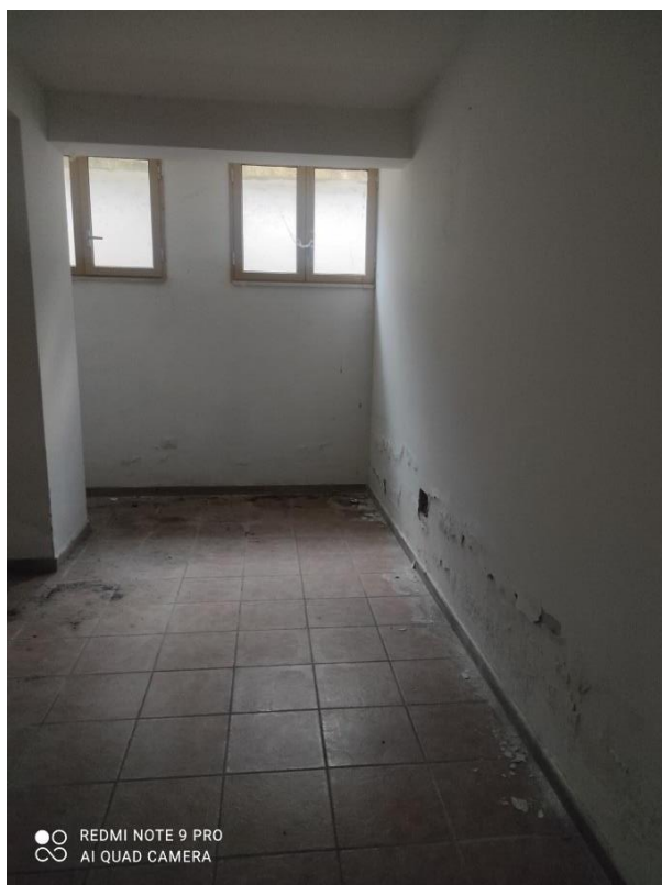
Foto n° 33 – porzione deposito piano S1 sub. n. 15 – Foto 24.03.2023
