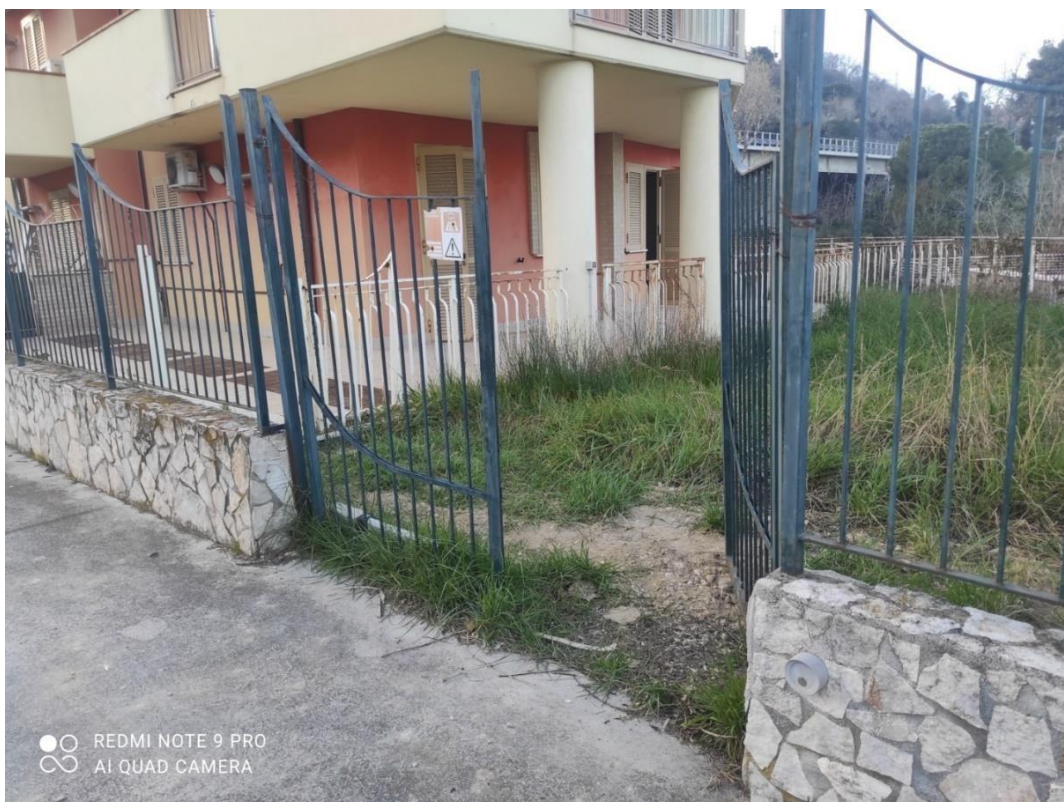
Foto n° 6 – edificio condominiale spigolo Sud-Est con corte privata del sub. 3 – Foto 24.03.2023
