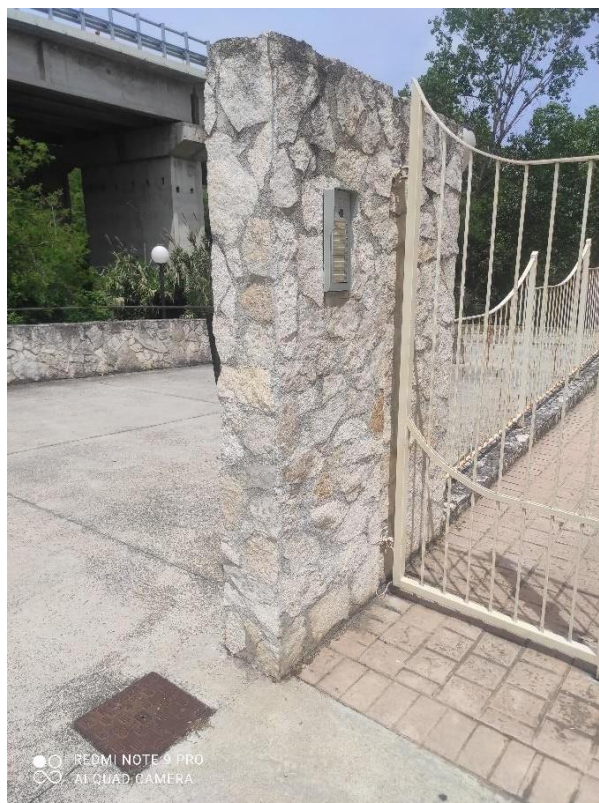
Foto n° 35 – complesso immobiliare foglio n. 9, particella n. 316 rapporto con A14 spigolo Sud-Ovest – Foto 30.05.2024
