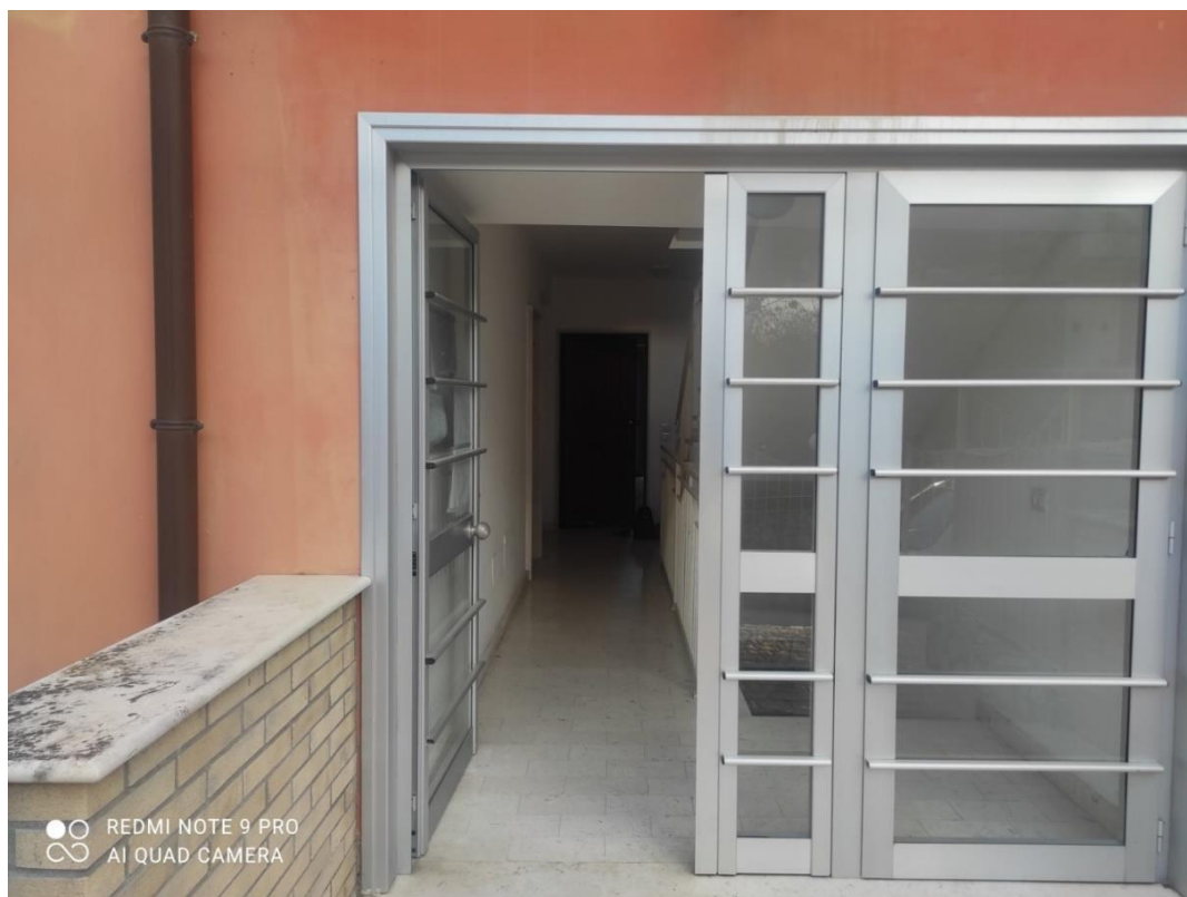
Foto n° 3 – ingresso condominiale su cortile lato Ovest – Foto 24.03.2023
