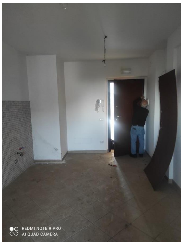
Foto n° 10 – ingresso appartamento piano terra sub. n. 3 – Foto 24.03.2023
