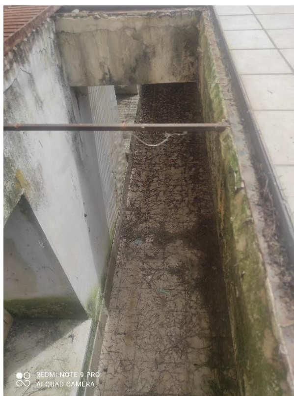
Foto n° 46 – bocche di lupo con infisso di collegamento piano T sub. n. 3 e piano S1 sub. n. 15 – Foto 30.05.2024
