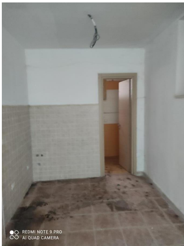
Foto n° 29 – porzione deposito piano S1 sub. n. 15 – Foto 24.03.2023
