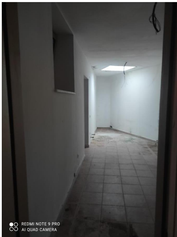
Foto n° 28 – porzione deposito piano S1 sub. n. 15 sottostante al lastrico solare lato Est dell'appartamento al piano terra sub. n. 3, con apertura vetrata atta ad accogliere la prevista scala a chiocciola di collegamento – Foto 24.03.2023
