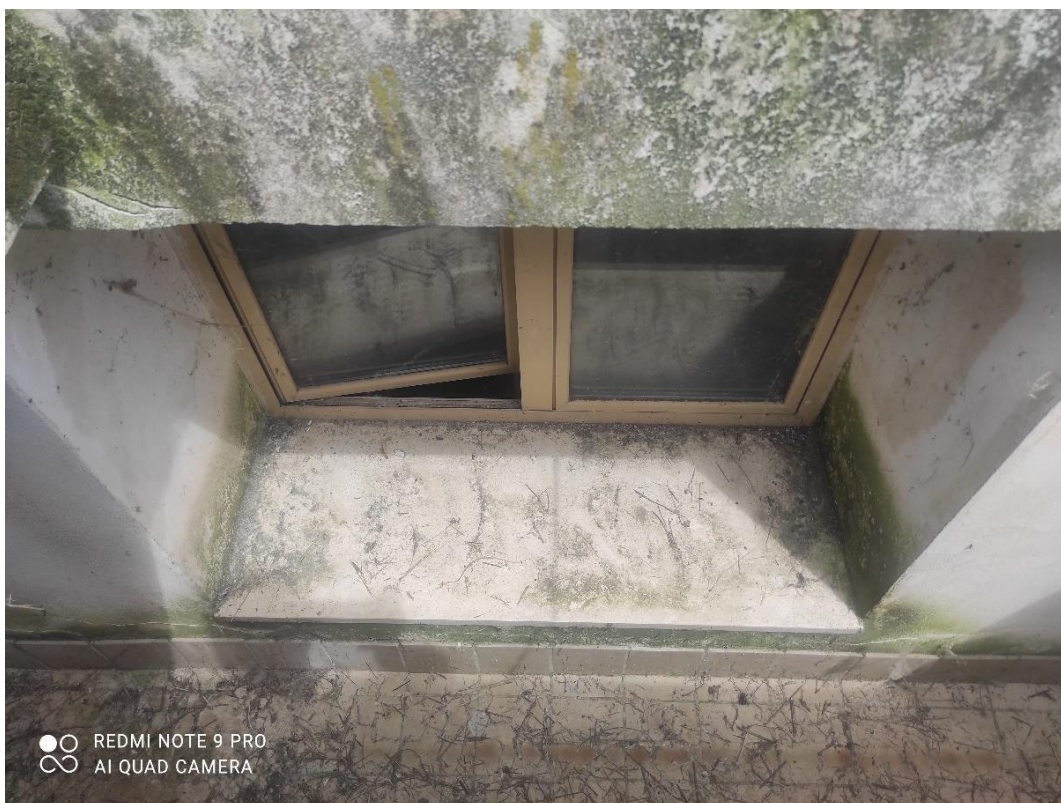
Foto n° 45 – bocche di lupo con infisso di collegamento piano T sub. n. 3 e piano S1 sub. n. 15 – Foto 30.05.2024
