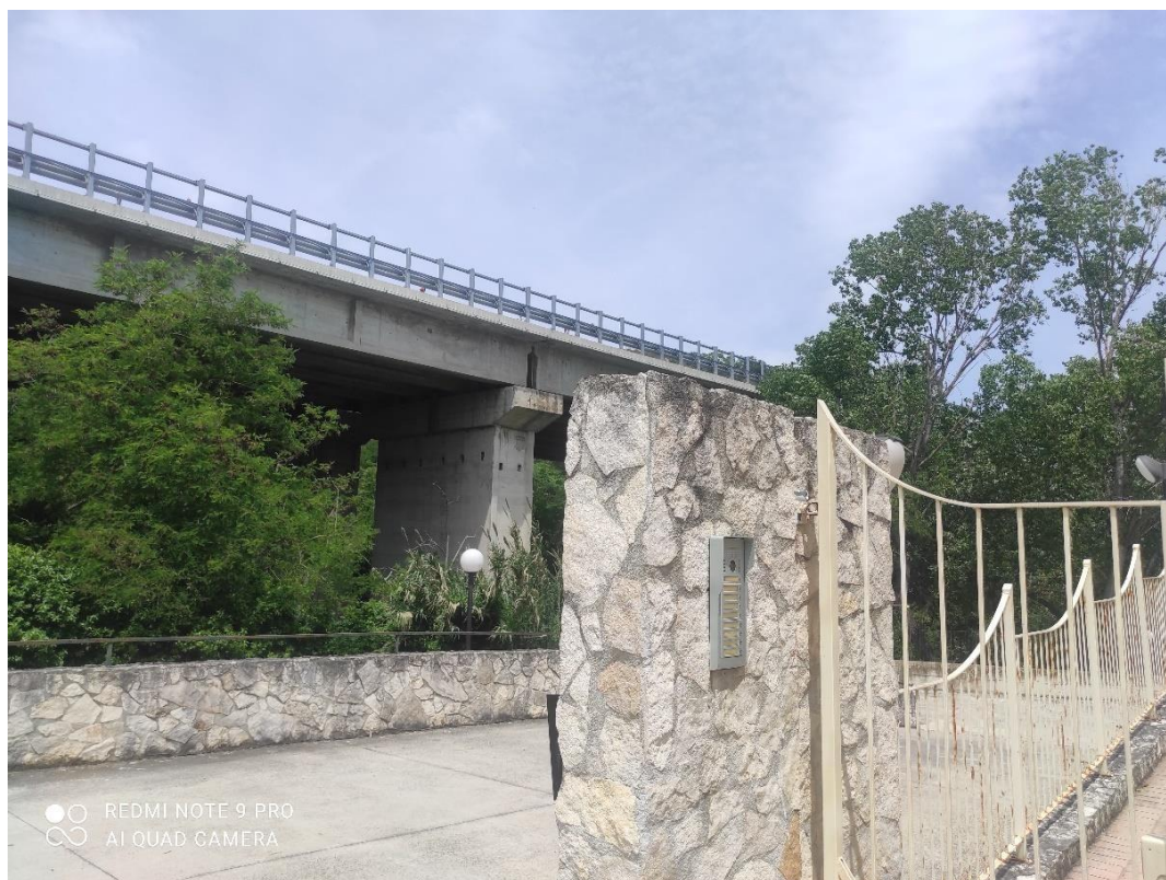
Foto n° 36 – complesso immobiliare foglio n. 9, particella n. 316 rapporto con A14 lato-Ovest – Foto 30.05.2024
