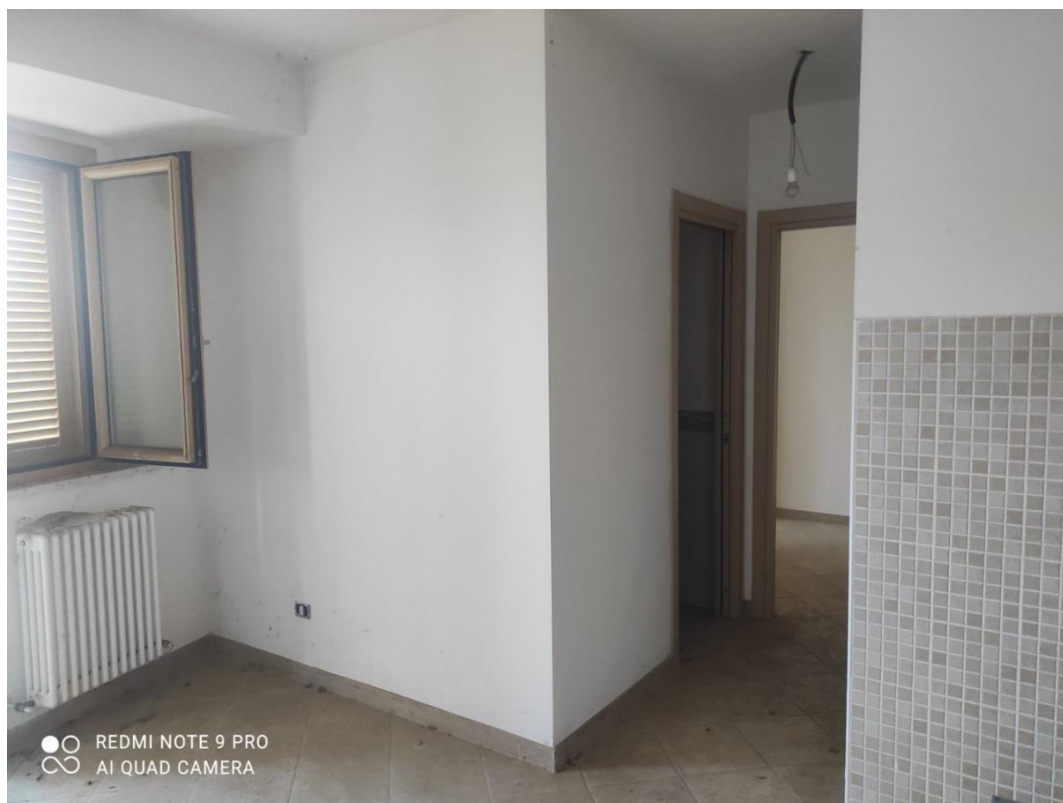
Foto n° 20 – disimpegno appartamento piano terra sub. n. 3 – Foto 24.03.2023
