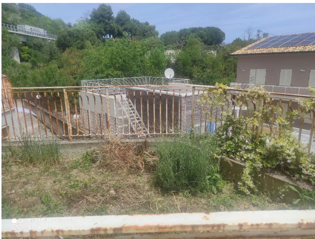
Foto n° 37 complesso immobiliare foglio n. 9, particella n. 316, rapporto con A14 spigolo Nord-Est – Foto 30.05.2024
