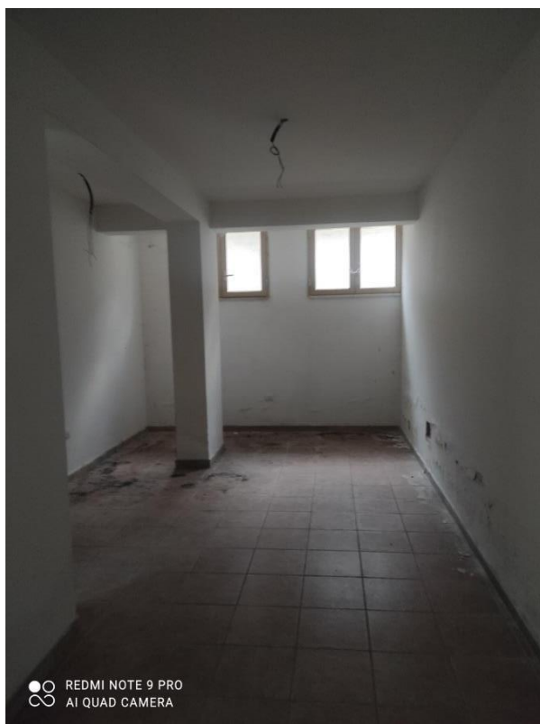
Foto n° 32 – porzione deposito piano S1 sub. n. 15 – Foto 24.03.2023
