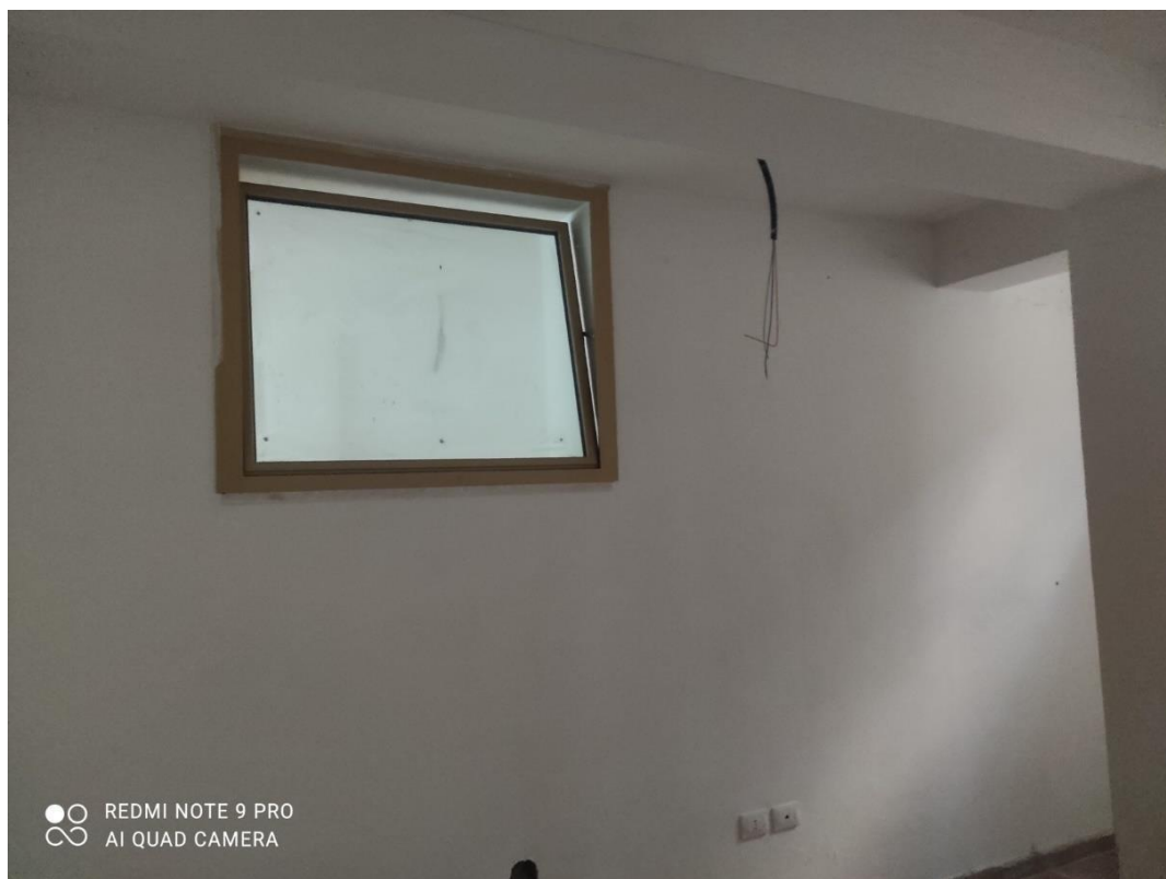
Foto n° 34 – porzione deposito piano S1 sub. n. 15 – Foto 24.03.2023
