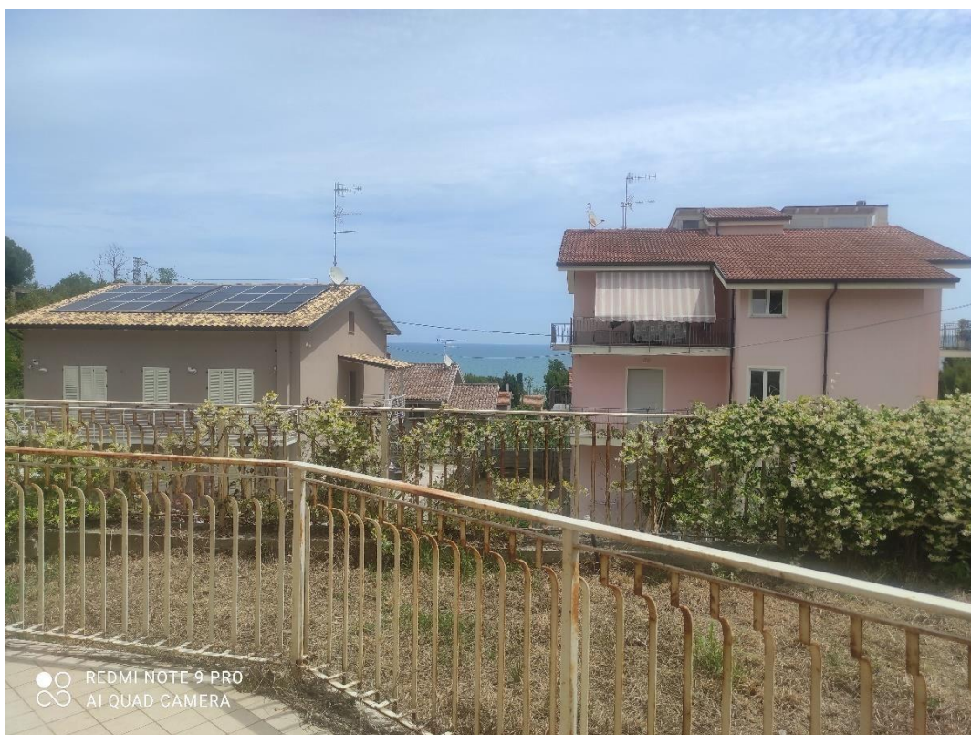
Foto n° 39 – complesso immobiliare foglio n. 9, particella n. 316, vista mare lato Est – Foto 30.05.2024
