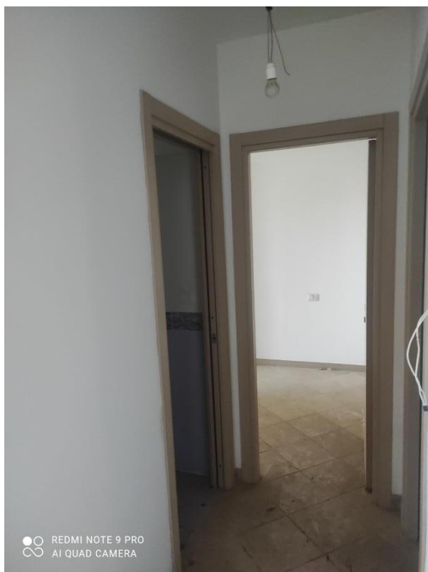
Foto n° 12 – disimpegno appartamento piano terra sub. n. 3 – Foto 24.03.2023
