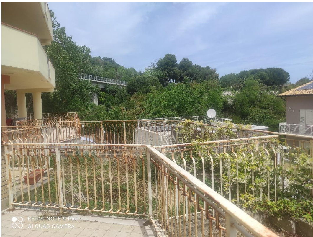
Foto n° 38 complesso immobiliare foglio n. 9, particella n. 316, rapporto con A14 spigolo Nord-Est – porzione deposito piano S1 sub. n. 15 – Foto 30.05.2024
