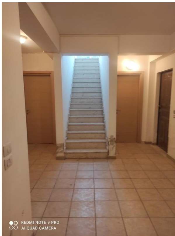
Foto n° 25 – scala condominiale di accesso al piano S1 – Foto 24.03.2023
