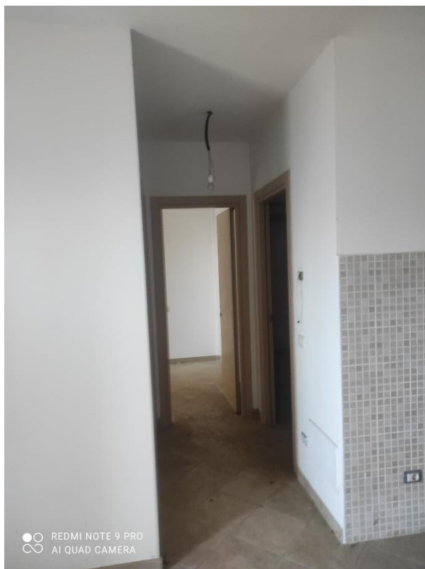
Foto n° 11 – disimpegno appartamento piano terra sub. n. 3 – Foto 24.03.2023
