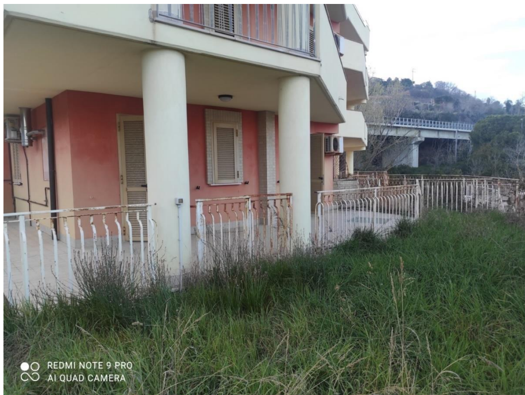
Foto n° 23 – corte esclusiva lato Est appartamento piano terra sub. n. 3 – Foto 24.03.2023
