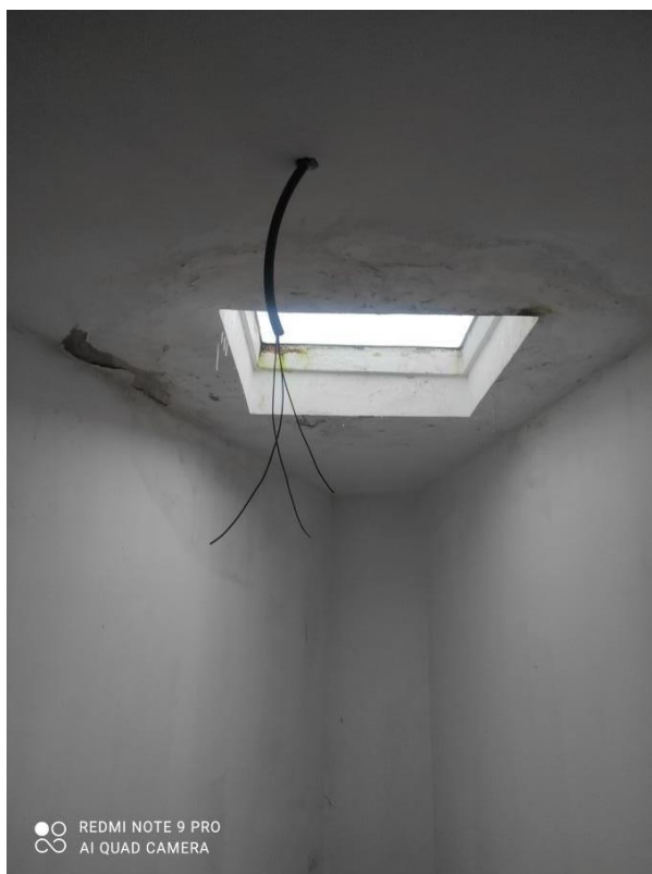
Foto n° 27 – porzione deposito piano S1 sub. n. 15 sottostante al lastrico solare lato Est dell'appartamento al piano terra sub. n. 3, con apertura vetrata atta ad accogliere la prevista scala a chiocciola di collegamento – Foto 24.03.2023
