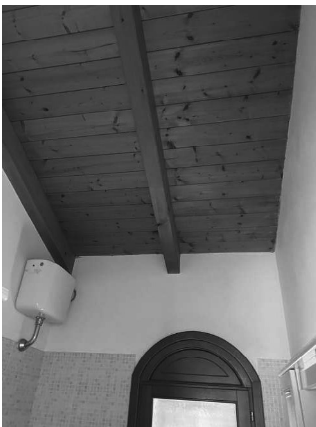
Foto 18. Immobile oggetto di esecuzione – vano bagno.
