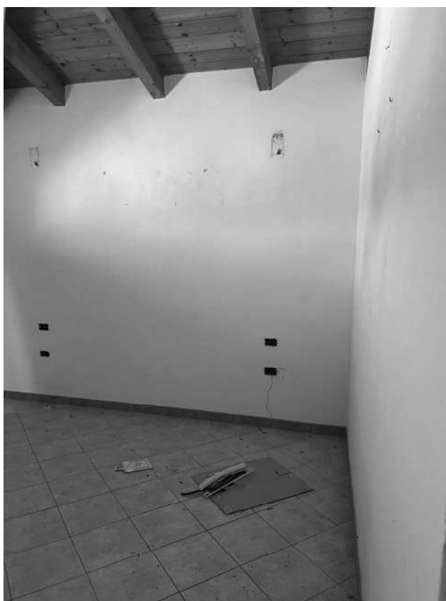
Foto 8. Immobile oggetto di esecuzione – vano camera da letto.
