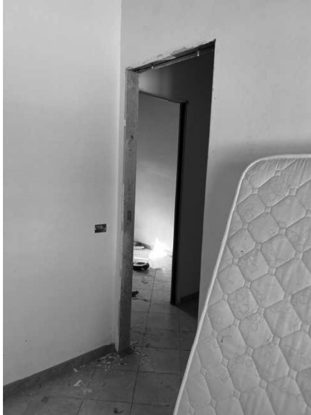
Foto 13. Immobile oggetto di esecuzione – vano camera da letto.
