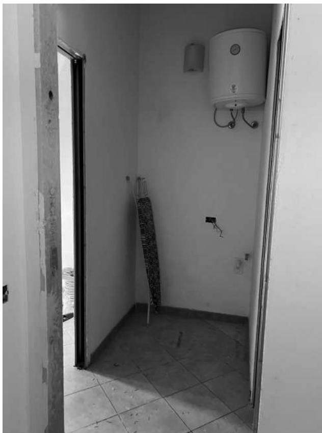
Foto 15. Immobile oggetto di esecuzione – vano disimpegno.
