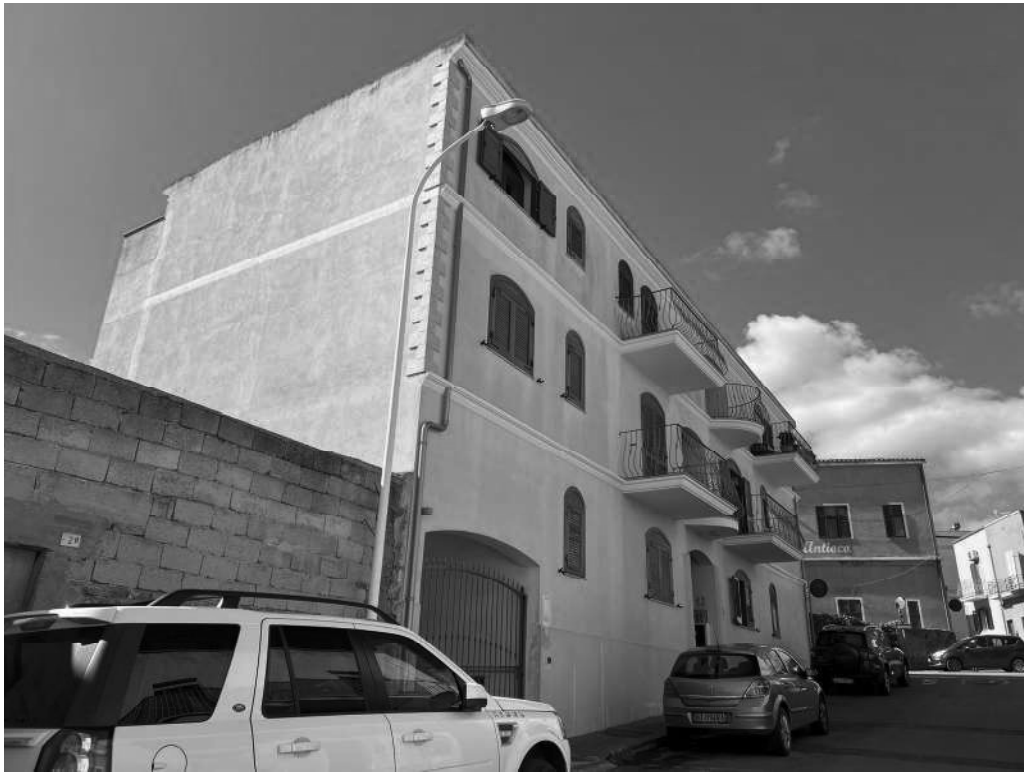
Foto 2. Fabbricato sito nel Comune di Sant'Antioco, via Massimo D'Azeglio.
