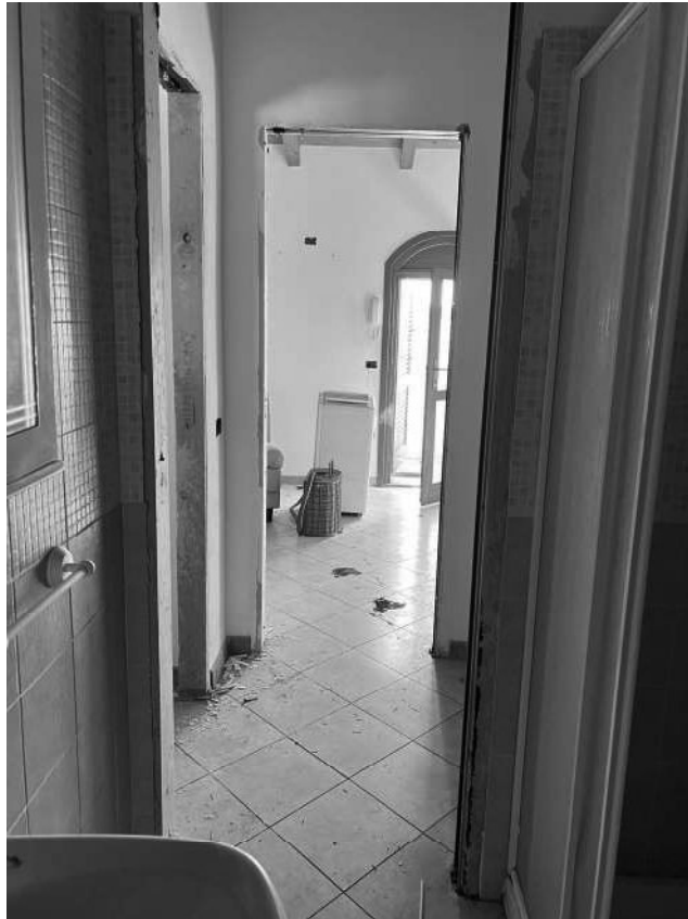
Foto 20. Immobile oggetto di esecuzione – vano bagno.
