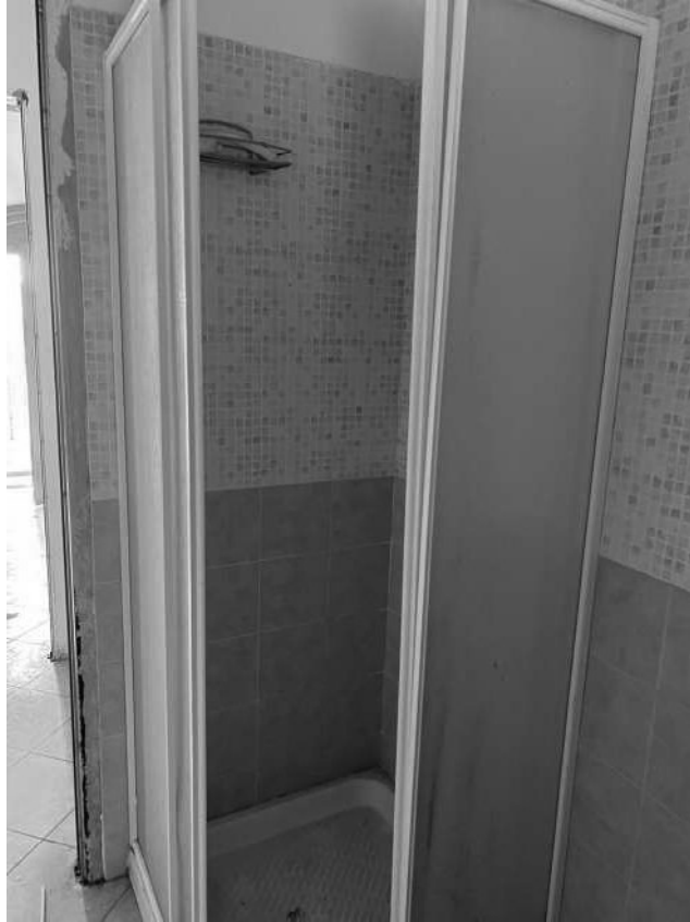
Foto 19. Immobile oggetto di esecuzione – vano bagno.
