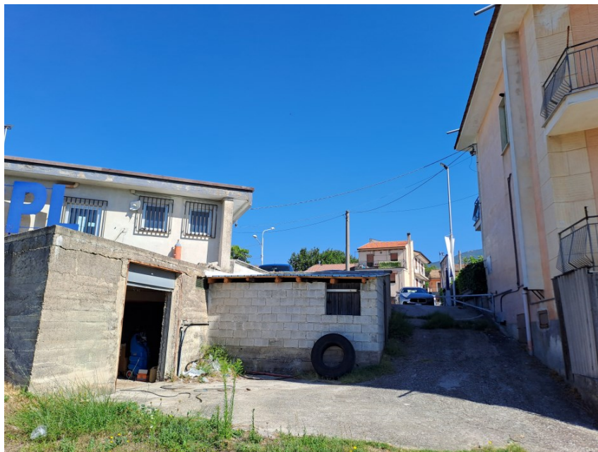
Fig.14_Foto bene 2 Deposito Piano Seminterrato con individuazione della rampa di accesso ubicata sulla particella 937 intestata ad altra ditta
