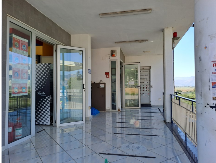
Fig.11_Foto bene 2 portico Piano Terra
