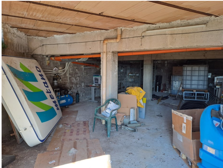
Fig.13_Foto bene 2 deposito Piano Seminterrato
