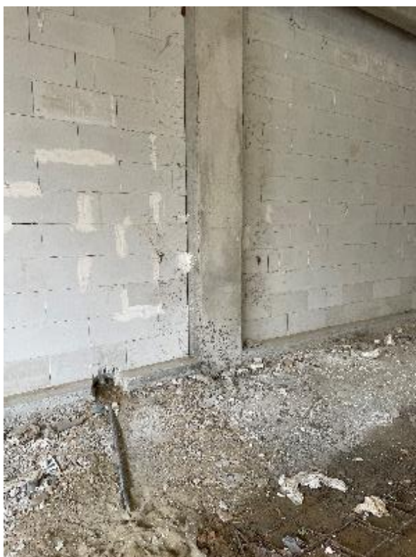
Lotto 2 - Particolare predisposizione impianti
