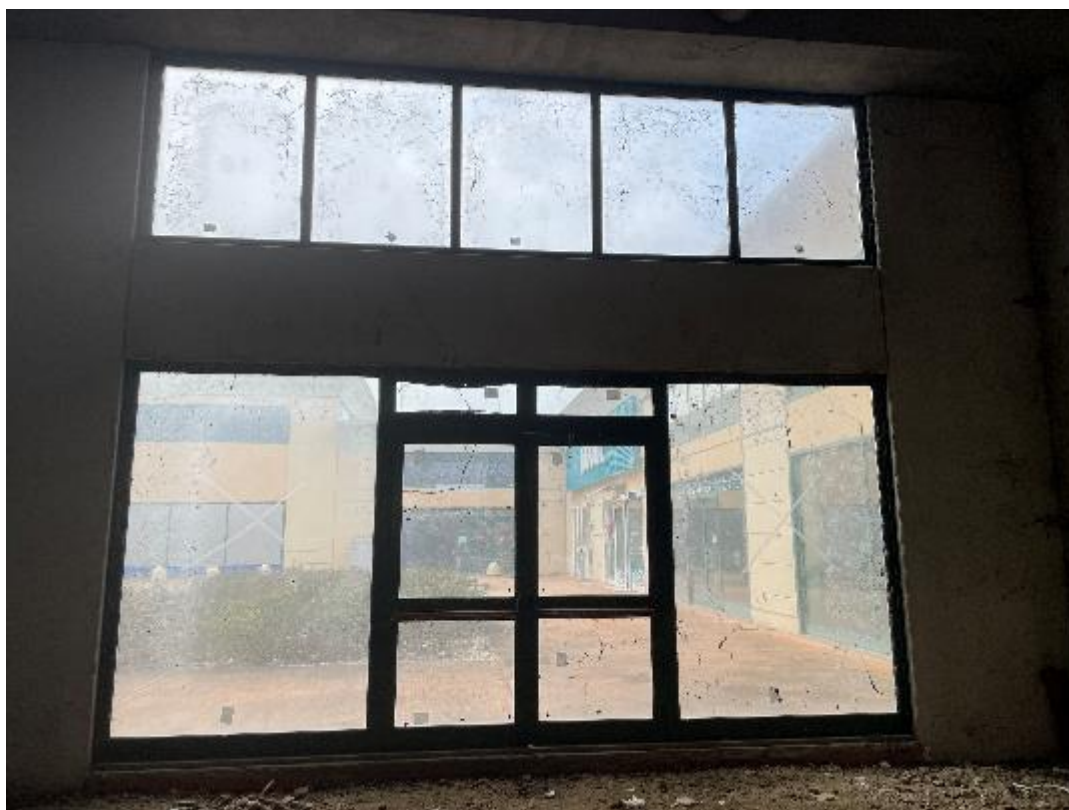
Lotto 2 – Particolare vetrata di accesso dal lato Ovest
