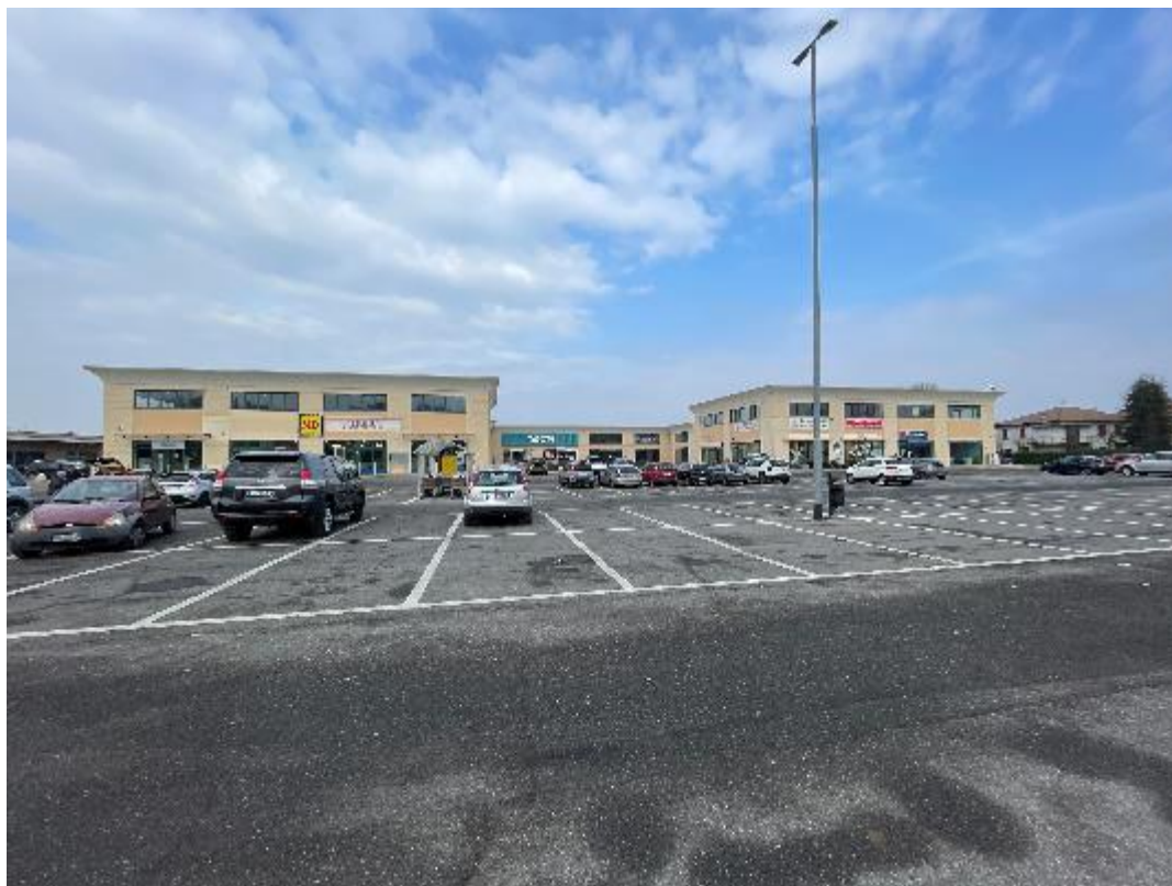
Complesso commerciale ingresso dalla Via Emilia
