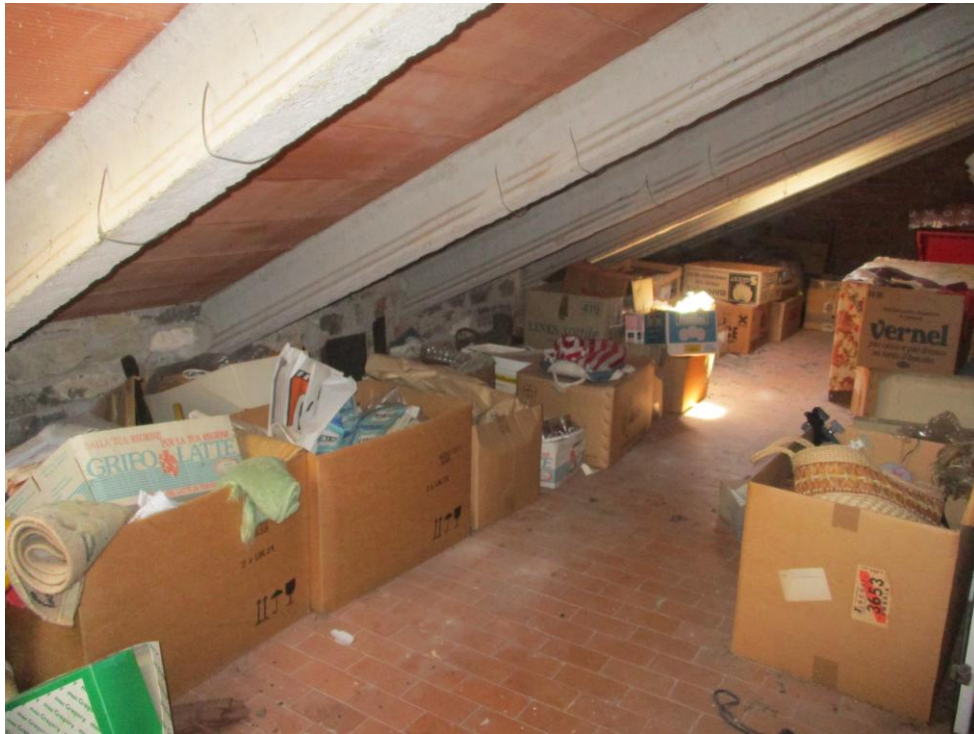
LOTTO 2 – VISTA INTERNA – SOTTOTETTO
