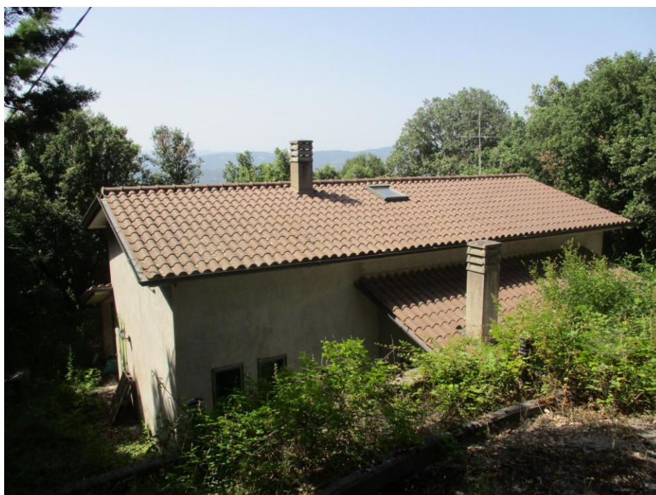
LOTTO 1 – VISTA ESTERNA – LATO RETRO
