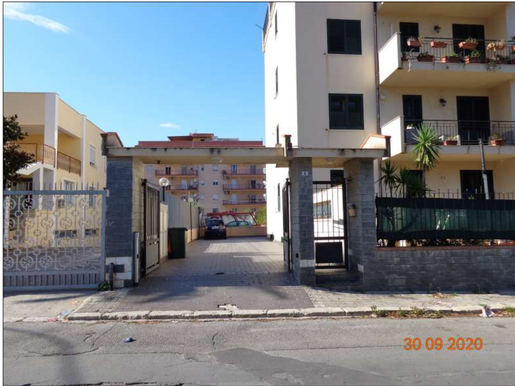
Foto n. 3 - Vista esterna dei cancelli di ingresso
