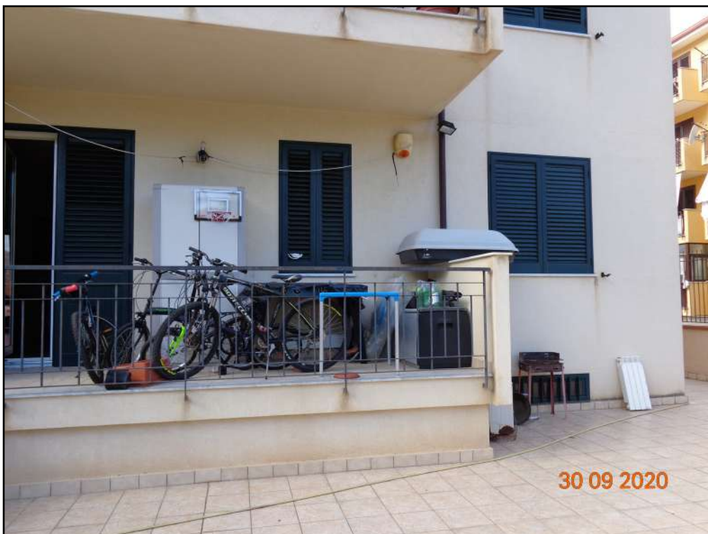
Foto n. 18 - Esterni: Balcone su corte di pertinenza
