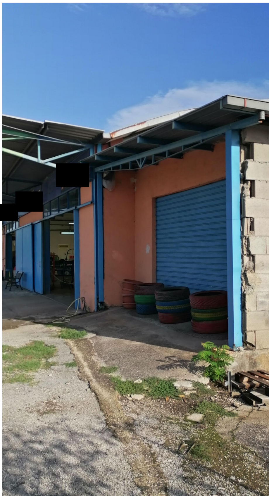
FOTO 3: Corpo C con tamponatura, vista anteriore
