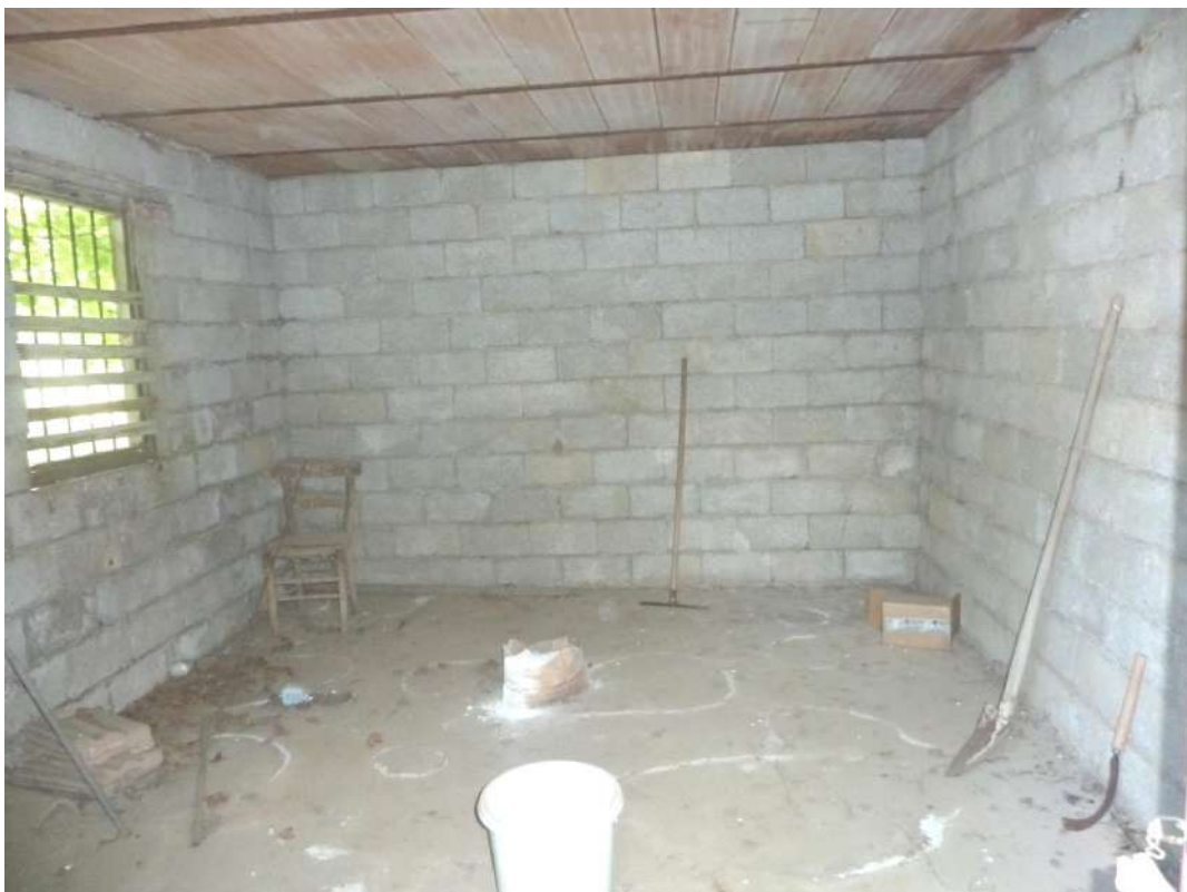
Foto n. 6 (Interno del deposito agricolo part.IIa 1329/1)
