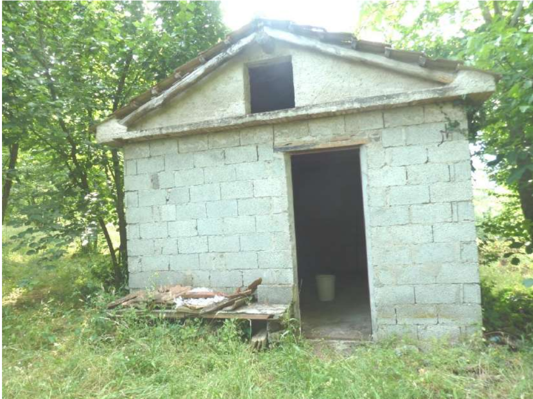
Foto n. 5 (Interno appezzamento n.1, part.IIe 1328-430-45-30-1329- vista del deposito agricolo part.IIa 1329/1)
