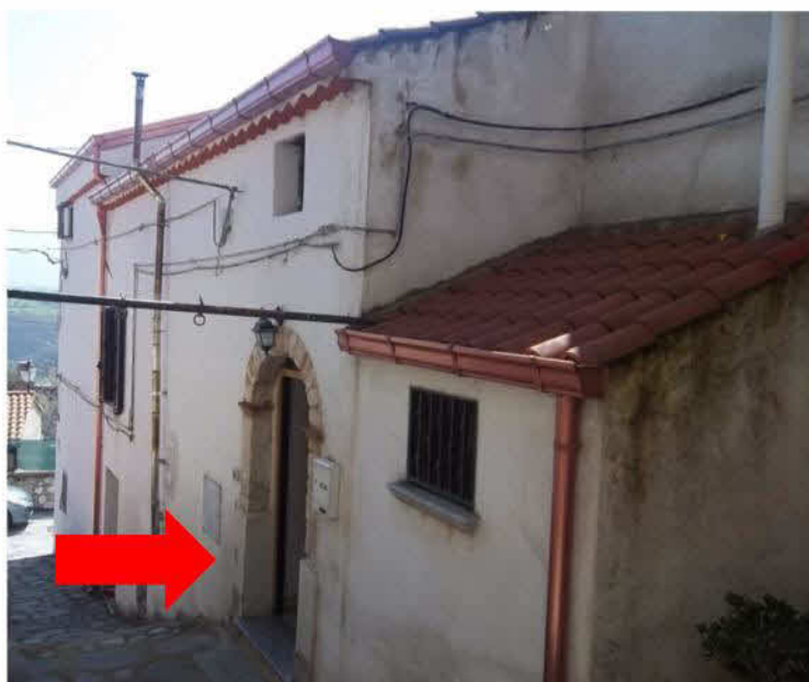
Figura 5 – Porta di accesso principale dello stabile
