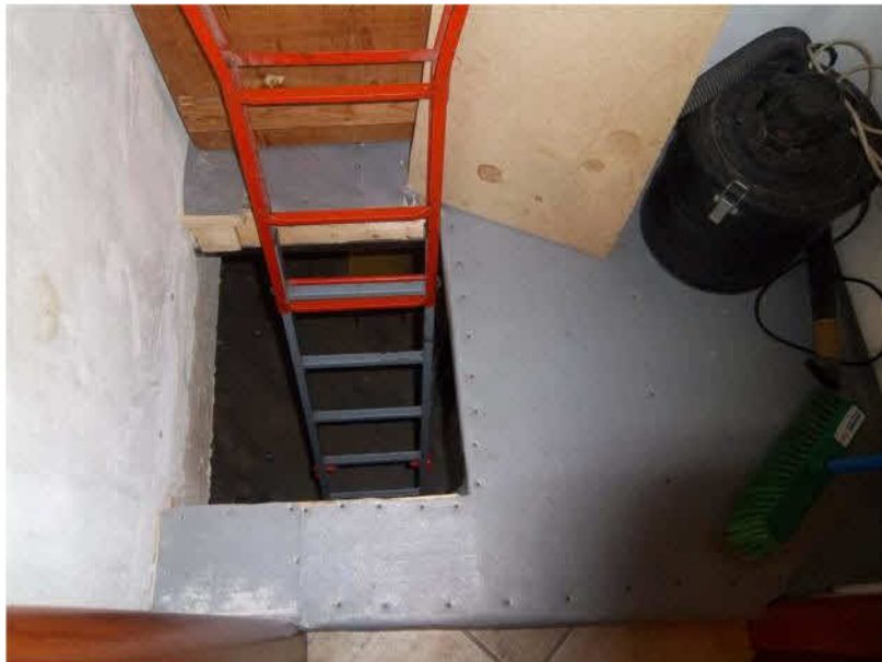
Figura 6 – Botola di collegamento tra il laboratorio e l'appartamento
