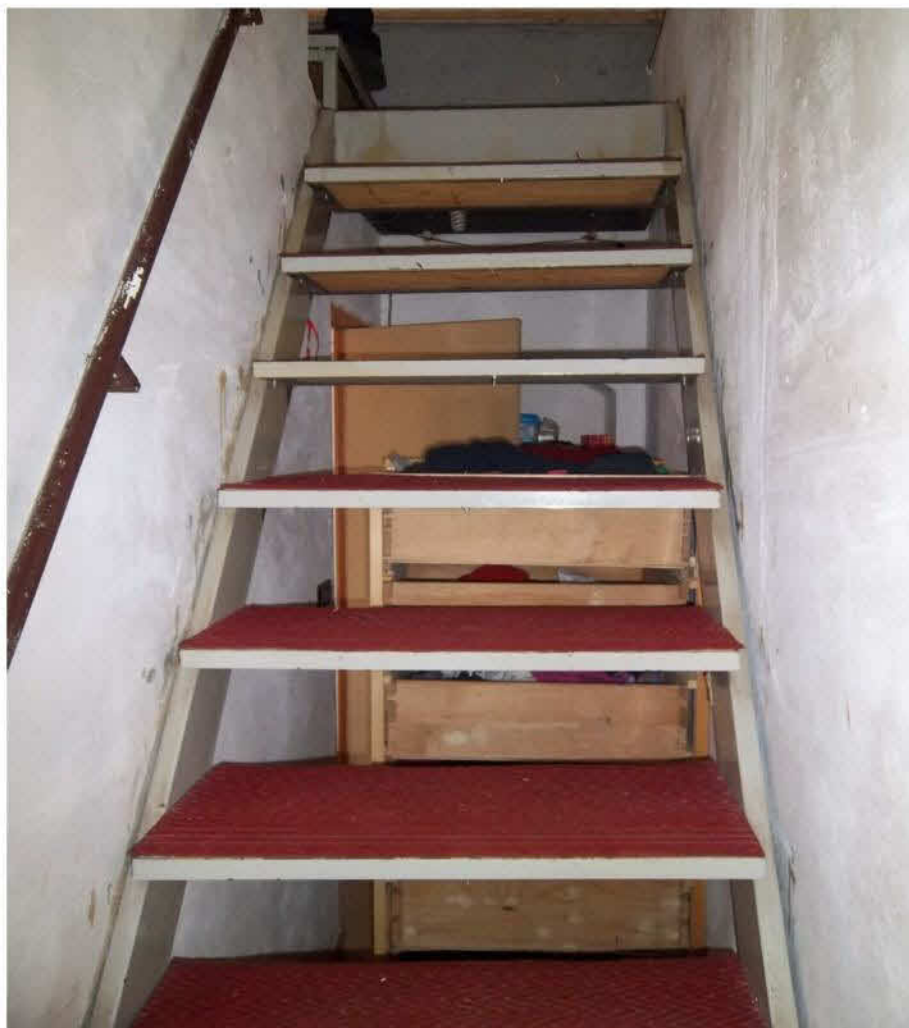
Figura 7 –Scala di collegamento in metallo tra piano primo e piano secondo
