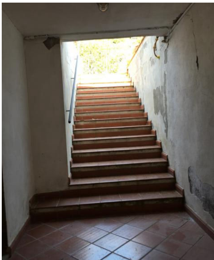
Foto n.18.3 - Scala di accesso al piano S1 da piazzale comune
