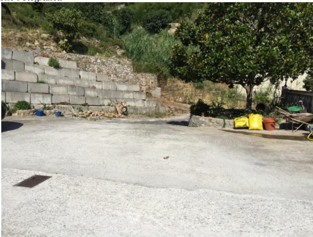
Foto n.9.3 - Rampa di accesso e piazzale comune
