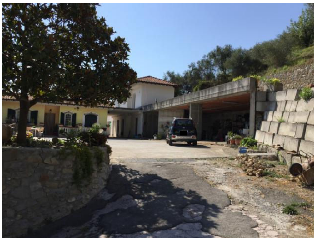
Foto n.8.3 - Rampa di accesso e piazzale comune
