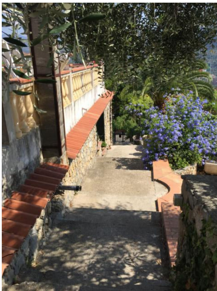
Foto n.14.3 - Scalinata di ingresso pedonale
