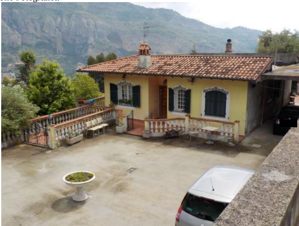
Foto n.11.3 - Piazzale comune lato nord, ingresso appartamento piano terra e scala di ingresso al piano S1
