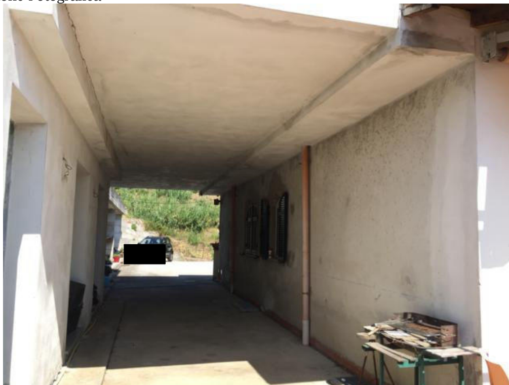
Foto n.19.4 - Portico dei sub.4-5 lato ovest
