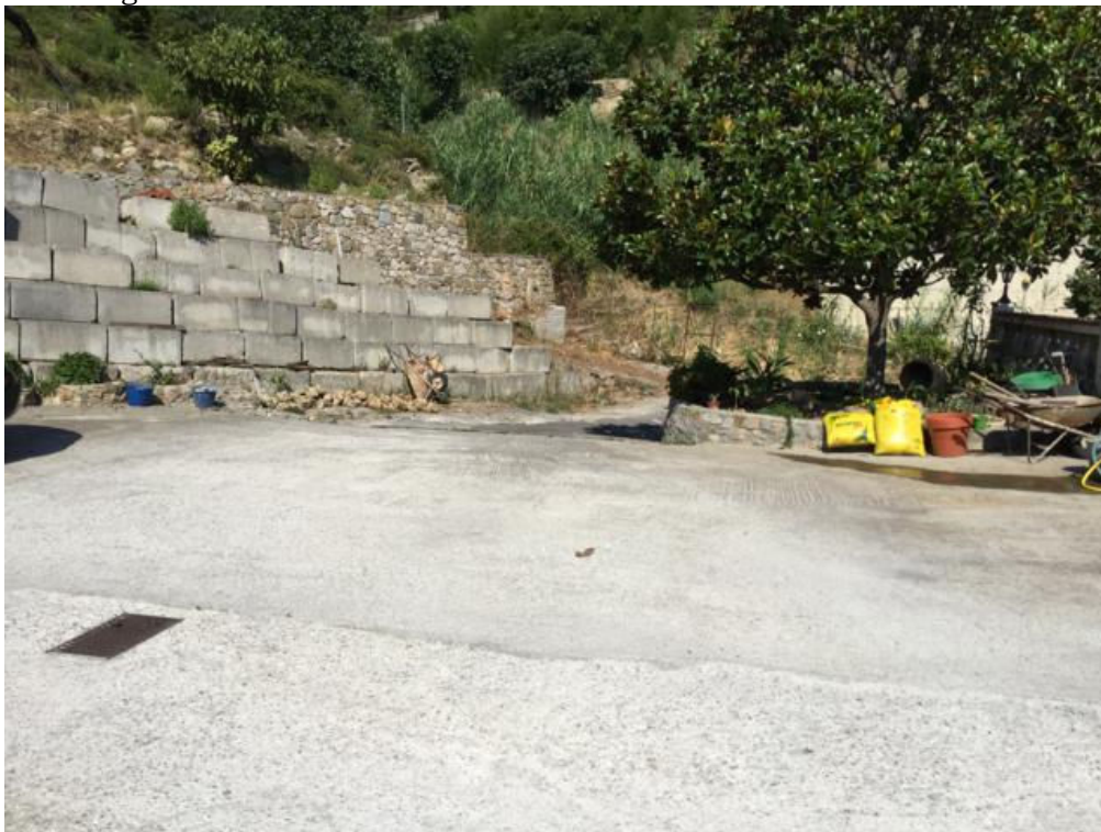
Foto n.9.4 - Rampa di accesso e piazzale comune
