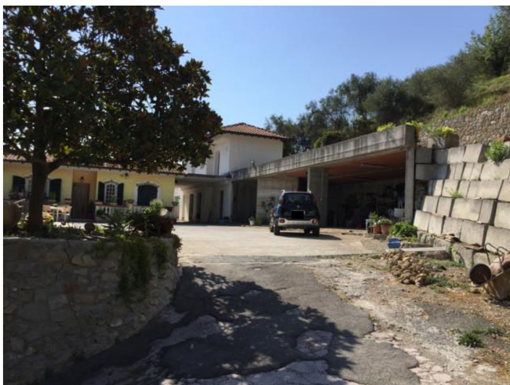
Foto n.8.4 - Rampa di accesso e piazzale comune
