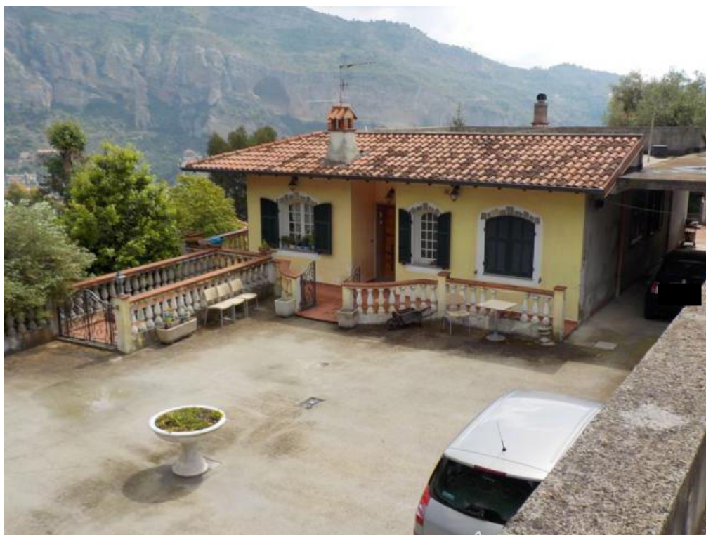
Foto n.20.4 - Piazzale comune lato nord, ingresso appartamento piano terra e scala di ingresso al piano S1
