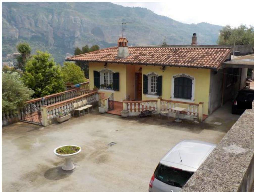
Foto n.11.4 - Piazzale comune lato nord, ingresso appartamento piano terra e scala di ingresso al piano S1
