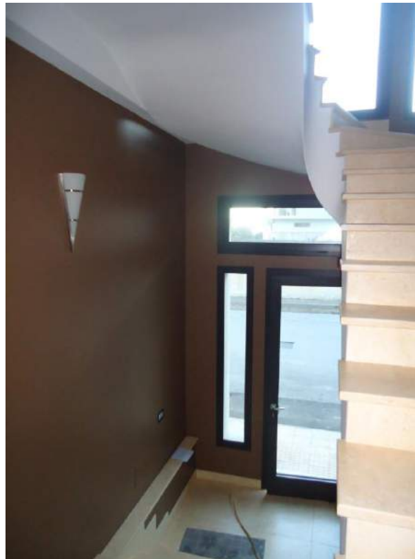
Foto n. 4 – Androne e vano scala
