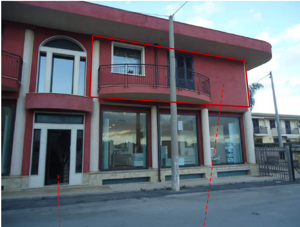
Foto n. 3 – Edificio di via Rinaldi
