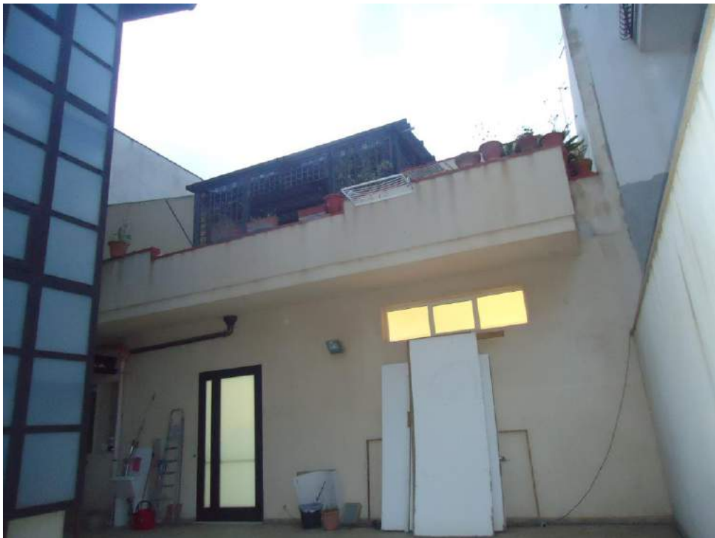
Foto n. 4 – Prospetto su cortile interno condominiale
